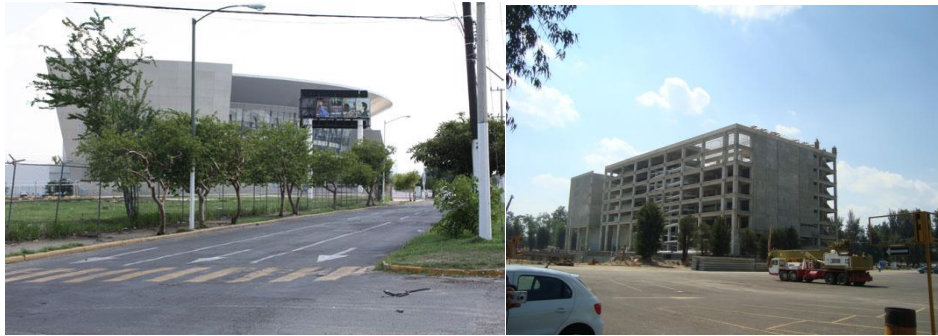
El auditorio Telmex i la biblioteca en construcción.
