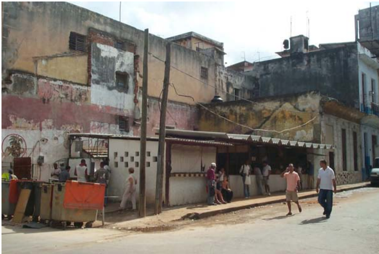
Imagen nº 4. Deterioro del fondo edificado y de la imagen urbana: alteración de las esquinas. Fuente: el autor
