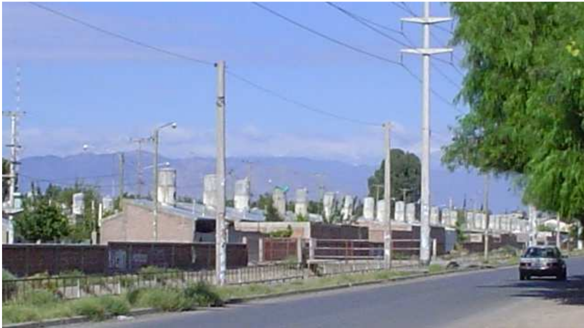
Ex Villa Costa Canal. Plan Arraigo, transferencia de tierras a sus ocupantes. Fuente: producción propia
