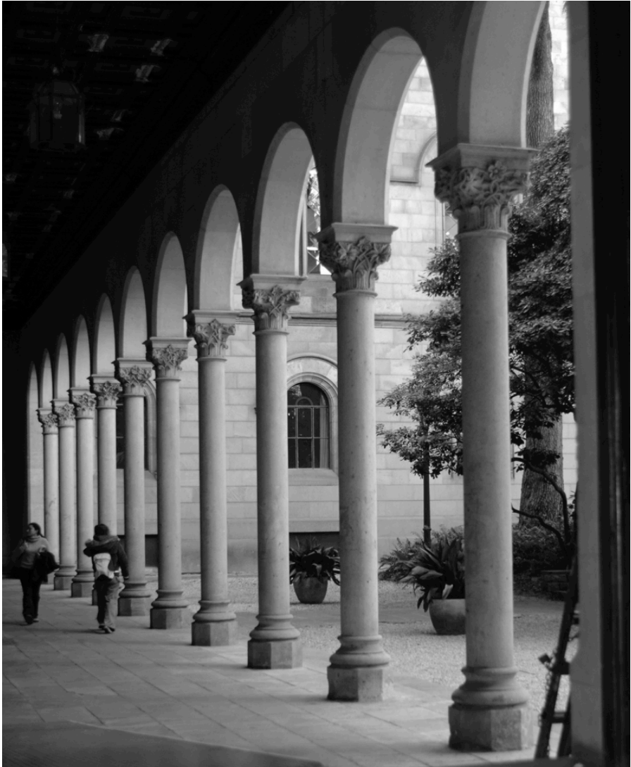
Fig. 3b Edificio histórico de la Universidad de Barcelona proyectado por Elias Rogent. Patio central.
