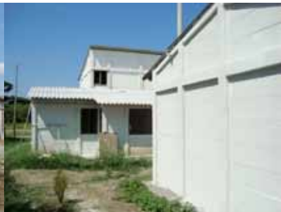
Fotografía 8. VISS construida con eco-materiales; aprovechamiento de cenizas volantes, escoria de hornos siderúrgicos, cerámicas descartadas para conducciones eléctricas. Palmira, Valle del Cauca.
