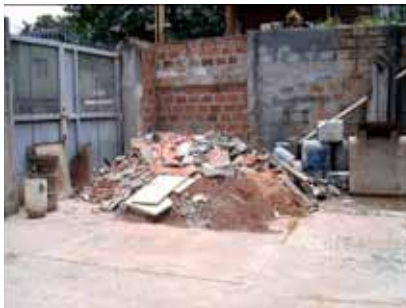
Fotografía 5. Escombros generados en empresa de prefabricados. Medellín, Antioquia.
