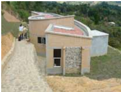
Fotografías 3. Vista general vivienda. Guarne, Antioquia.
