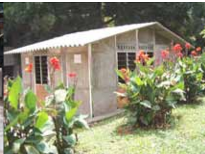
Fotografía 6. Vivienda construida con paneles de concreto reciclado. Medellín, Antioquia.
