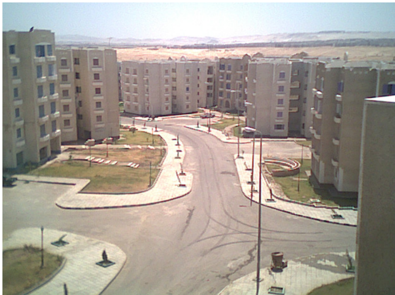
Figura 3. Ejemplo de Maladaptación: Edificación Popular Contemporánea en el Oriente Medio Fuente: Sánchez-Rodríguez, R. (2011).
