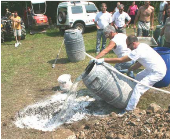
Figura 3. Vertido de 200 L de agua
