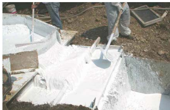
Figura 2. Decantación de la lechada de cal
