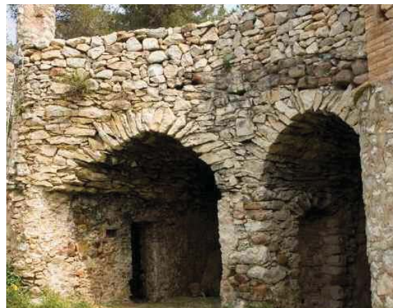
Foto 1. Hornos de cal de “CACIS” (2010). Hornos tradicionales que funcionaban de forma alterna y por tanto con un producción de la cal continua.
