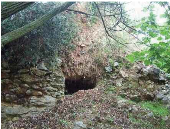
Foto 4.- Vista general del horno tal y como se encontró (abril 2010)
