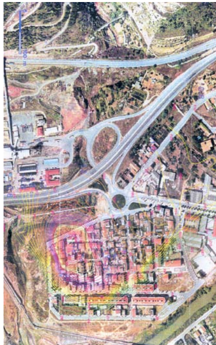
Aspecte de l'esfondrament del barri, mesurat pel Servei Geològic de l'ICC (Institut Cartogràfic de Catalunya)
