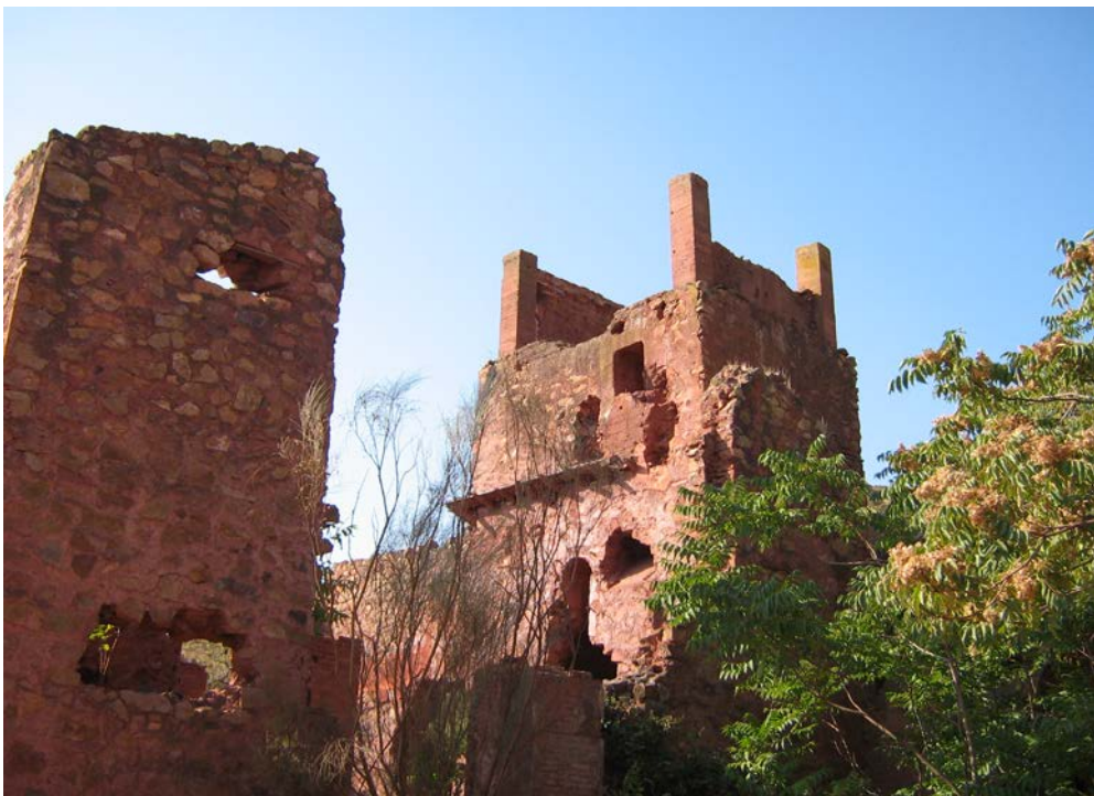
Fotografía 7. Otro aspecto de las instalaciones iniciales del teleférico minero
