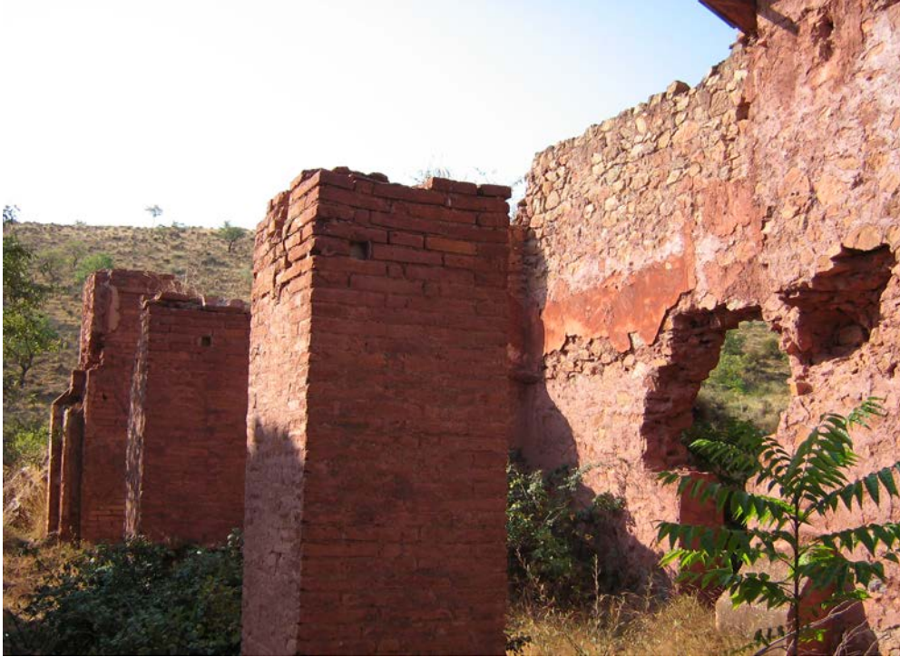
Fotografía 6. Aspecto general de la estación de salida del teleférico
