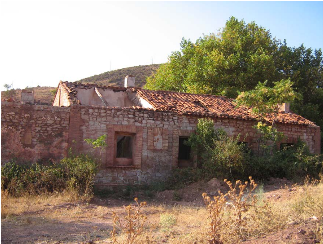
Fotografía 9. Uno de los edificios de las antiguas instalaciones mineras
