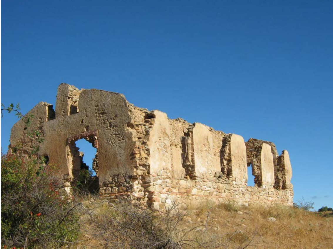
Fotografía 3. Restos de uno de los edificios de la estación intermedia
