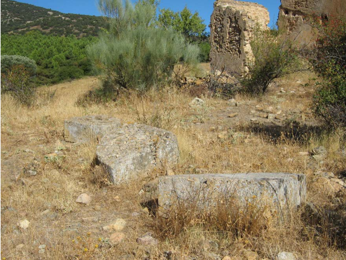
Fotografía 4. Restos de las pesas que eran utilizadas en la Estación Intermedia. Su misión era la de sujetar los cables del teleférico
