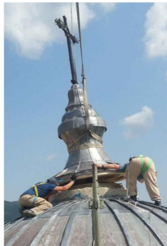
Fig. 6 . Proceso de restauración del pináculo de la capilla del Sagrario
