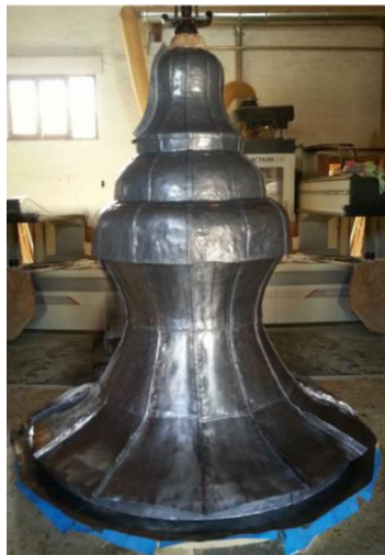
Fig. 6 . Proceso de restauración del pináculo de la capilla del Sagrario
