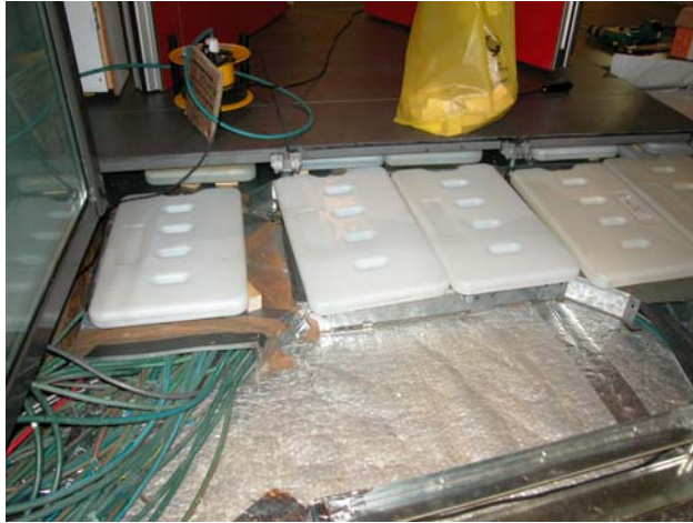
Colocación de cápsulas con los geles de cambio de estado
