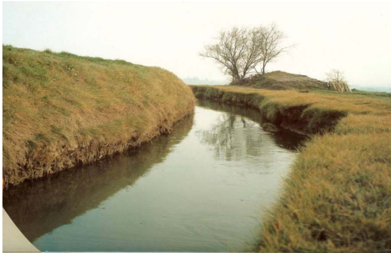
Fig. 1.- La Sèquia de Manresa, obra d'Enginyeria acabada el 1.383.
