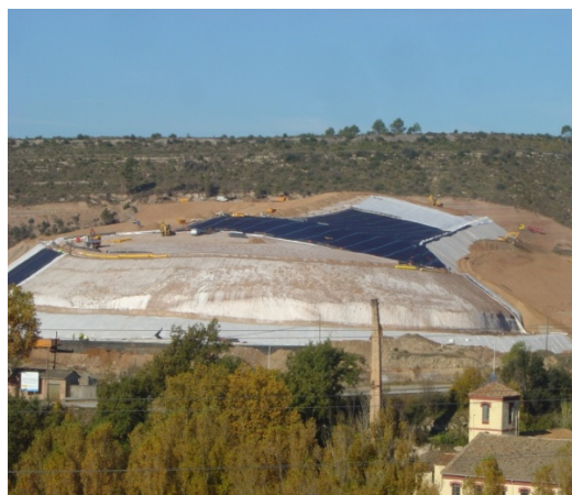
Fig. 5.- Cobriment amb polietilè i geotextil del runam de Vilafruns.
