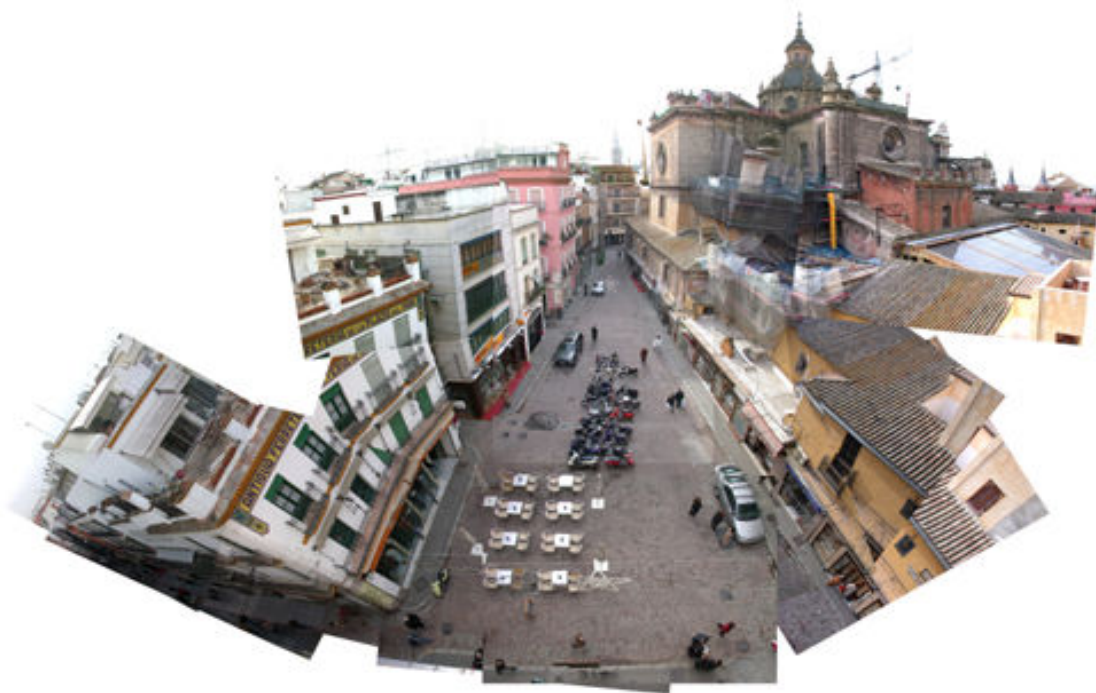
Plaza del Pan, vista general del estado antes de la intervención.
