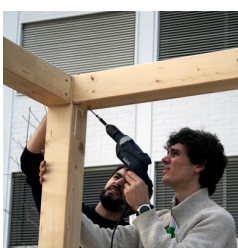
Muntatge unions estructura
