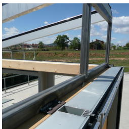
Estructura de la coberta inclinada
