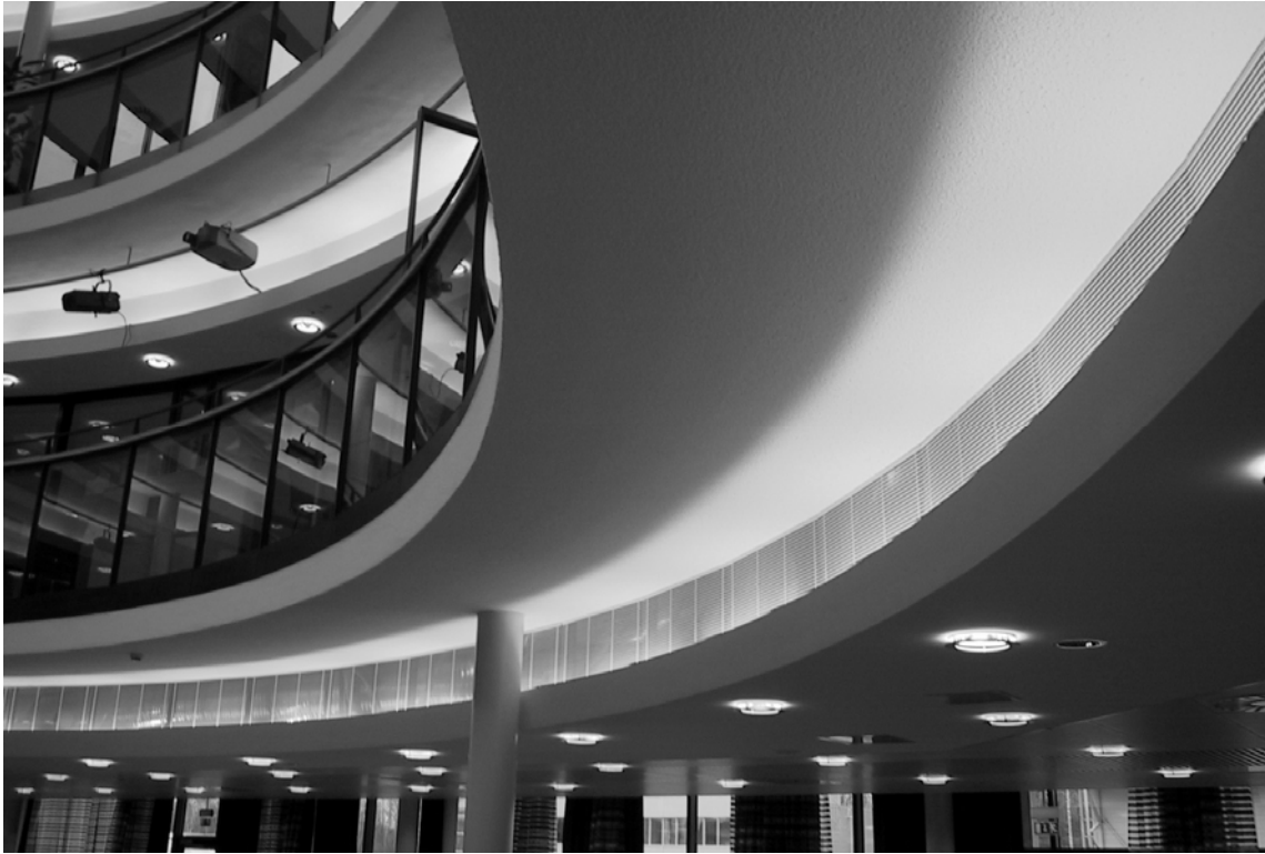
Kuva 5.15. Lukion kaikkea sisäistä liikennettä välittää neljä kerrosta korkea keskusaula, johon on yhdistetty ruokala, kirjasto ja ryhmätyötiloja. Aulan kaikki seinä- ja kattopinnat on vaimennettu. Mineraalivilla on päällystetty ruiskutteella, jolloin on saatu aikaan tasaisia saumattomia pintoja. Järvenpään lukio.
