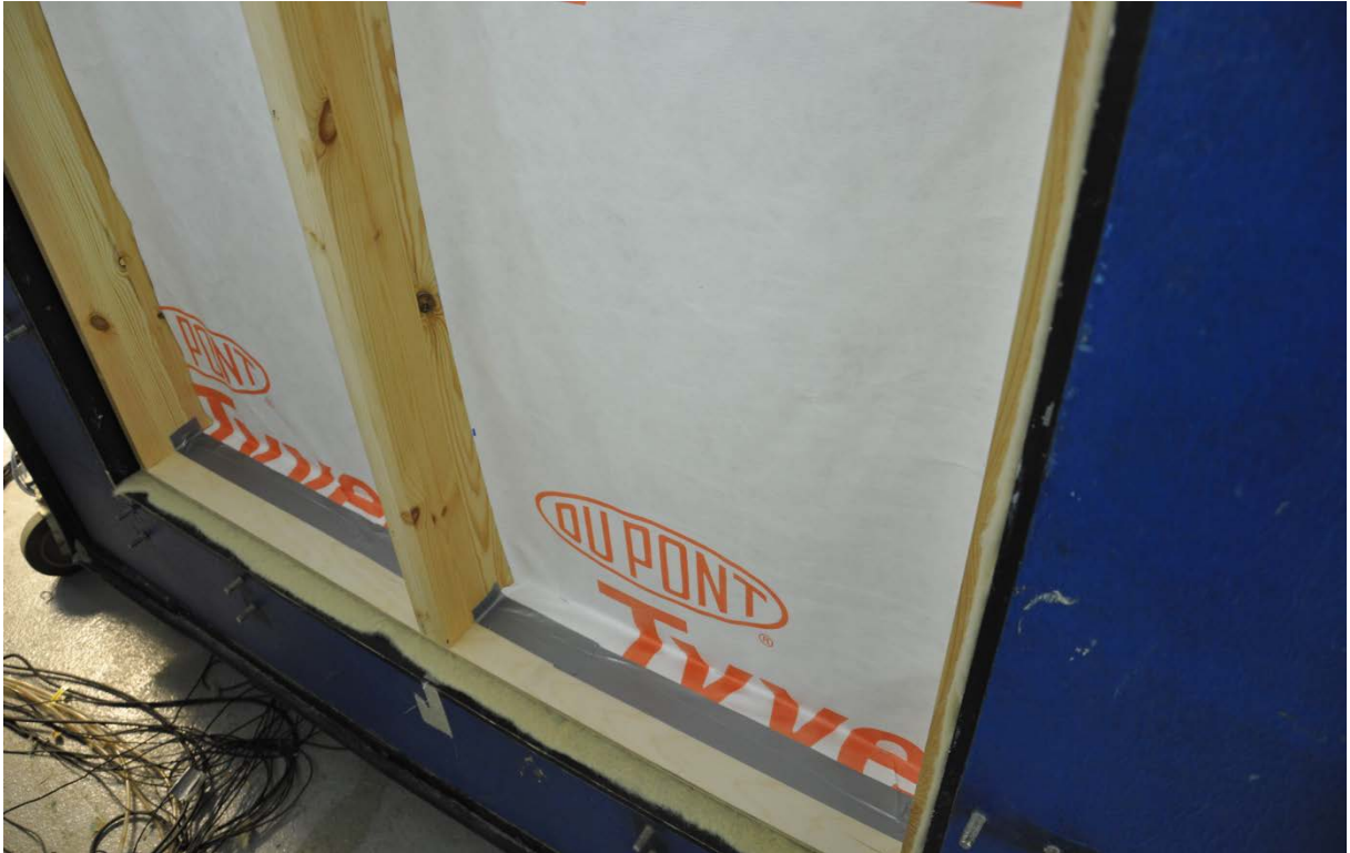
Kuva 7.3.8 Konvektiokatko asennettuna koerakenteeseen.
