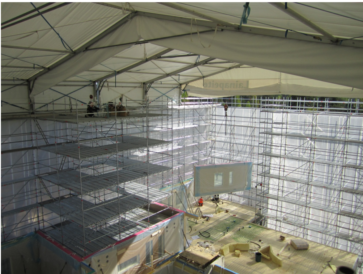
Kuva 9.1.4 Puukerrostalon rakentamista sääsuojassa.
