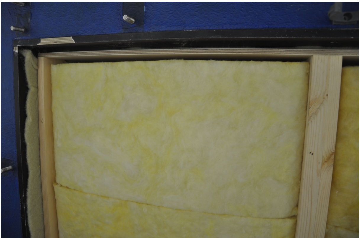
Kuva 7.3.9 Mineraalivillalla eristetty koerakenne, jossa näkyy lämmöneristekerroksen läpäisevä ilmarako yläreunassa.
