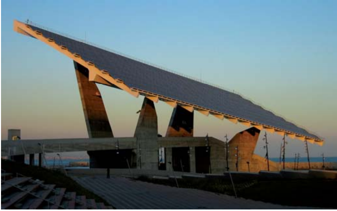
Figura 5: Vista de la pèrgola fotovoltaica
