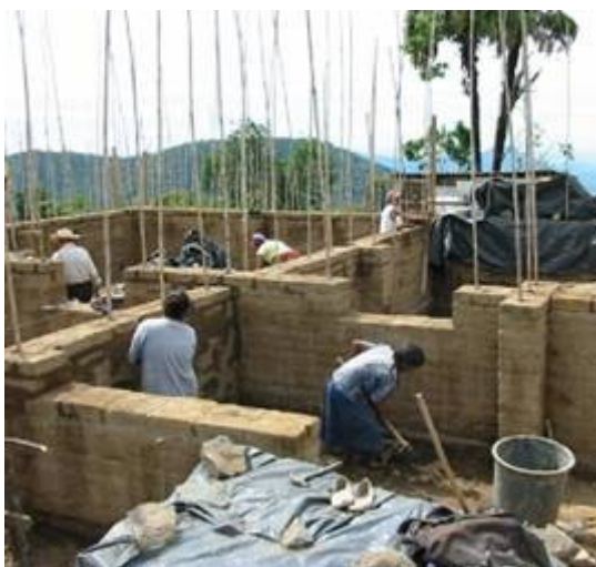
Imagen 3. El proceso constructivo de ayuda mutua con adobe sismorresistente
