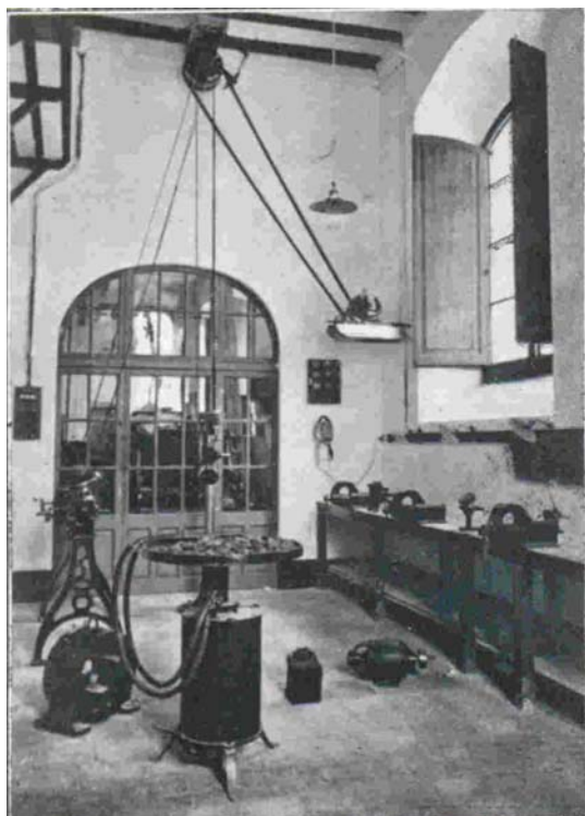
Figura 3. Taller de construccions elèctriques
