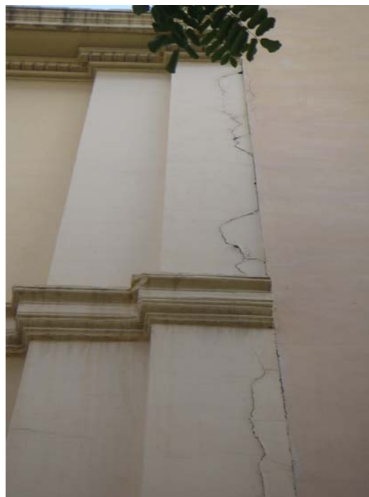
Apertura de juntas entre edificios (siglo XVIII) ocasionadas por “inyecciones de cemento preventivas”.
