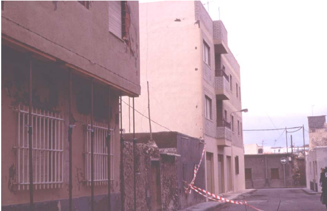
Foto 7.2 Edificio vecino del anterior, sin daños excesivos.
