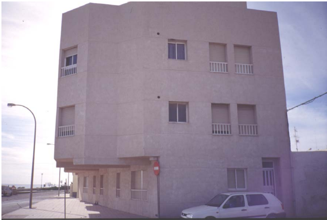
Foto 7.3 Irregularidad en planta: crecimiento de las plantas con la altura.
