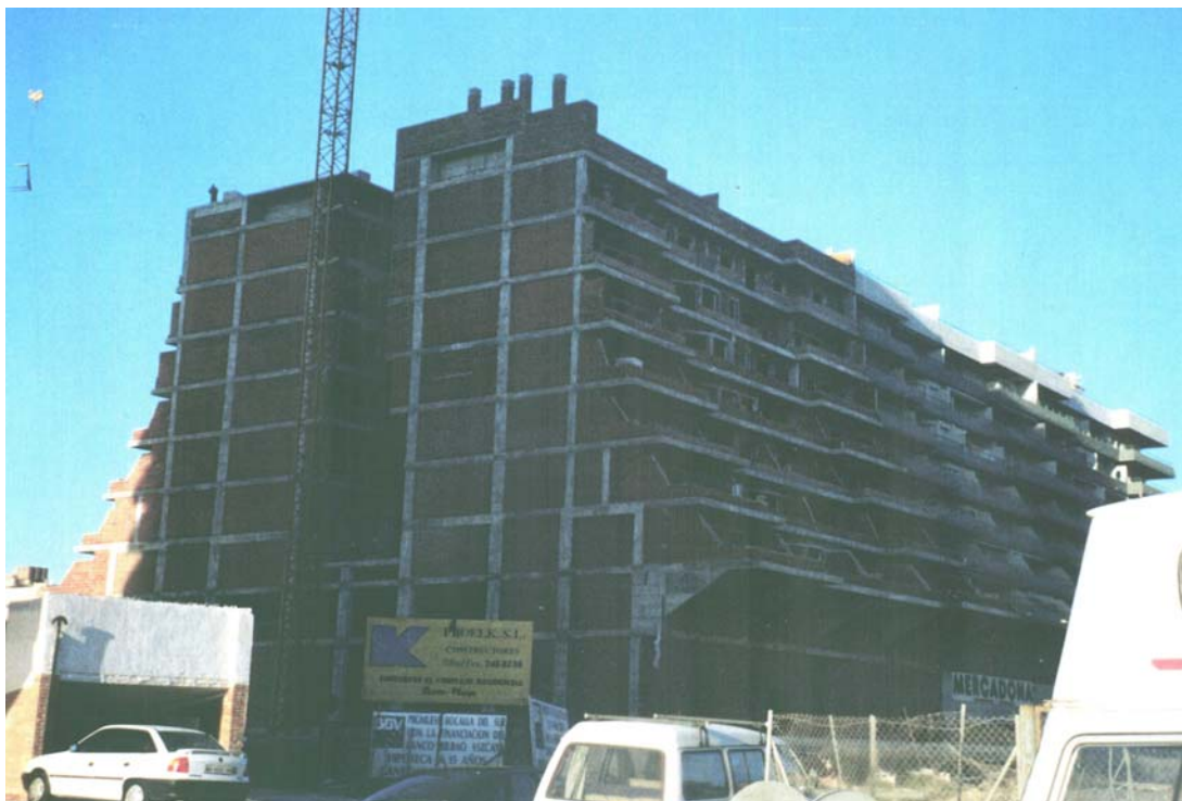
Foto 7.4 Crecimiento de plantas y discontinuidad en líneas resistentes verticales.
