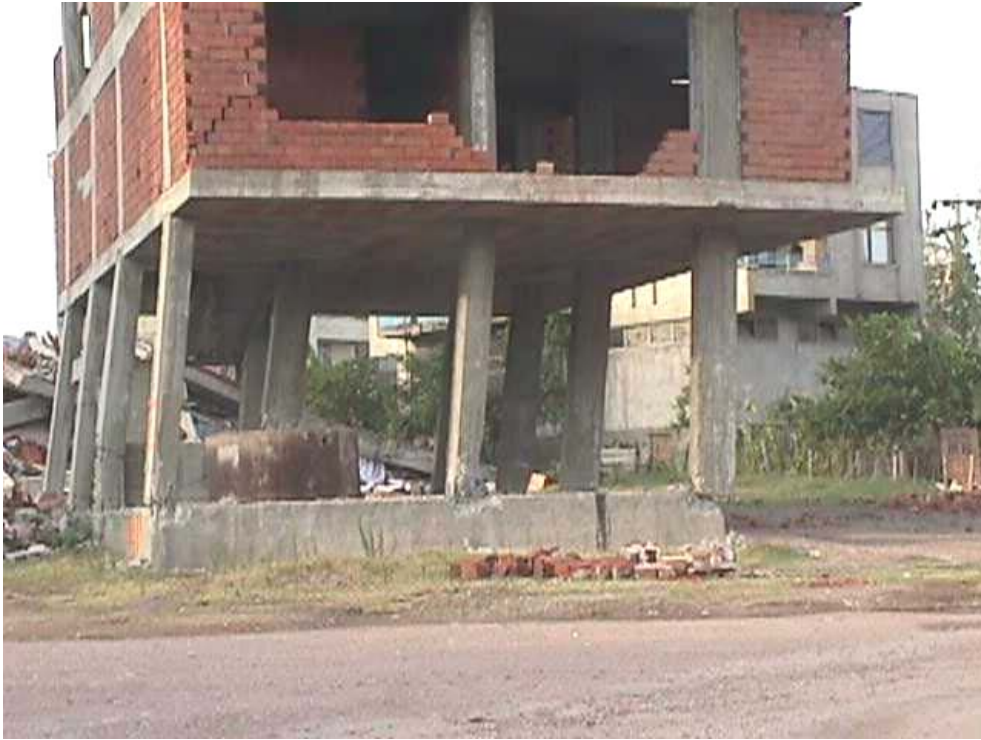
Foto 7.13 Formación de rótula plástica en extremos de pilar.
