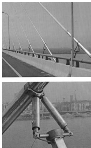
Fig. 6-29 Amortiguadores MR en puente Dongting Lake (Spencer y Nagarajaiah, 2003)
