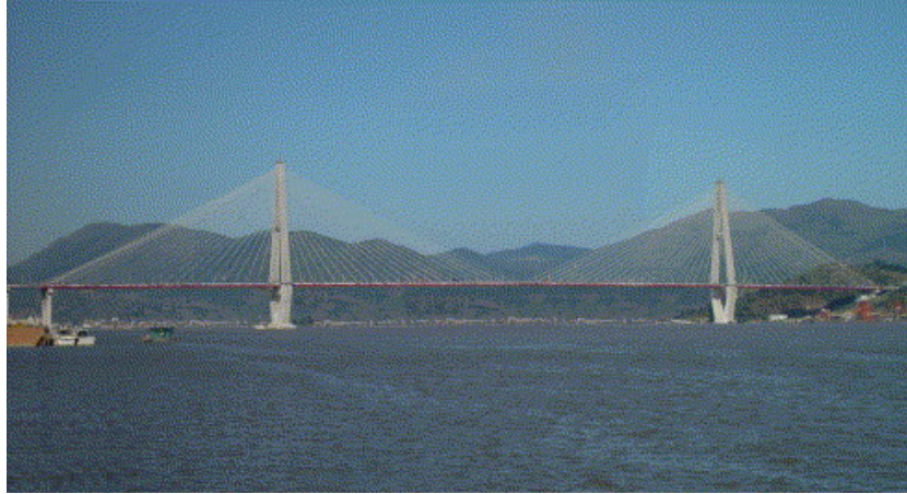
Fig. 3-1 Vista general del puente Qingzhen (Ren et al, 2005)
