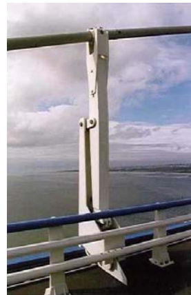
Fig. 6-21 Amortiguador hidráulico externo (Lecinq et al, 2003)
