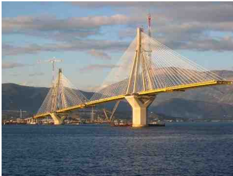
Fig. 6-13 Vista general del puente Rion-Antirión (Infanti et al , 2004)
