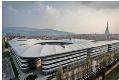
Campus Luigi Einaudi Turin, Italy, source: formTL ingenieure für tragwerk und leichtbau GmbH, © Michele D'Ottavio
