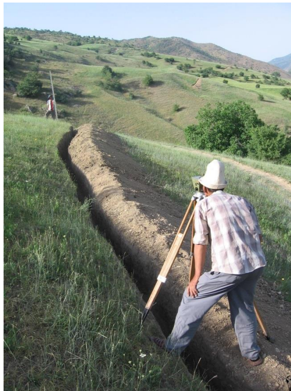
Figura 1. EWB-UK ayudas voluntarias en la topografía para la colocación de 6 km de tuberías para dar agua potable a una comunidad de 3000 personas South Kyrgyzstan. (EWB-UK, 2008)
