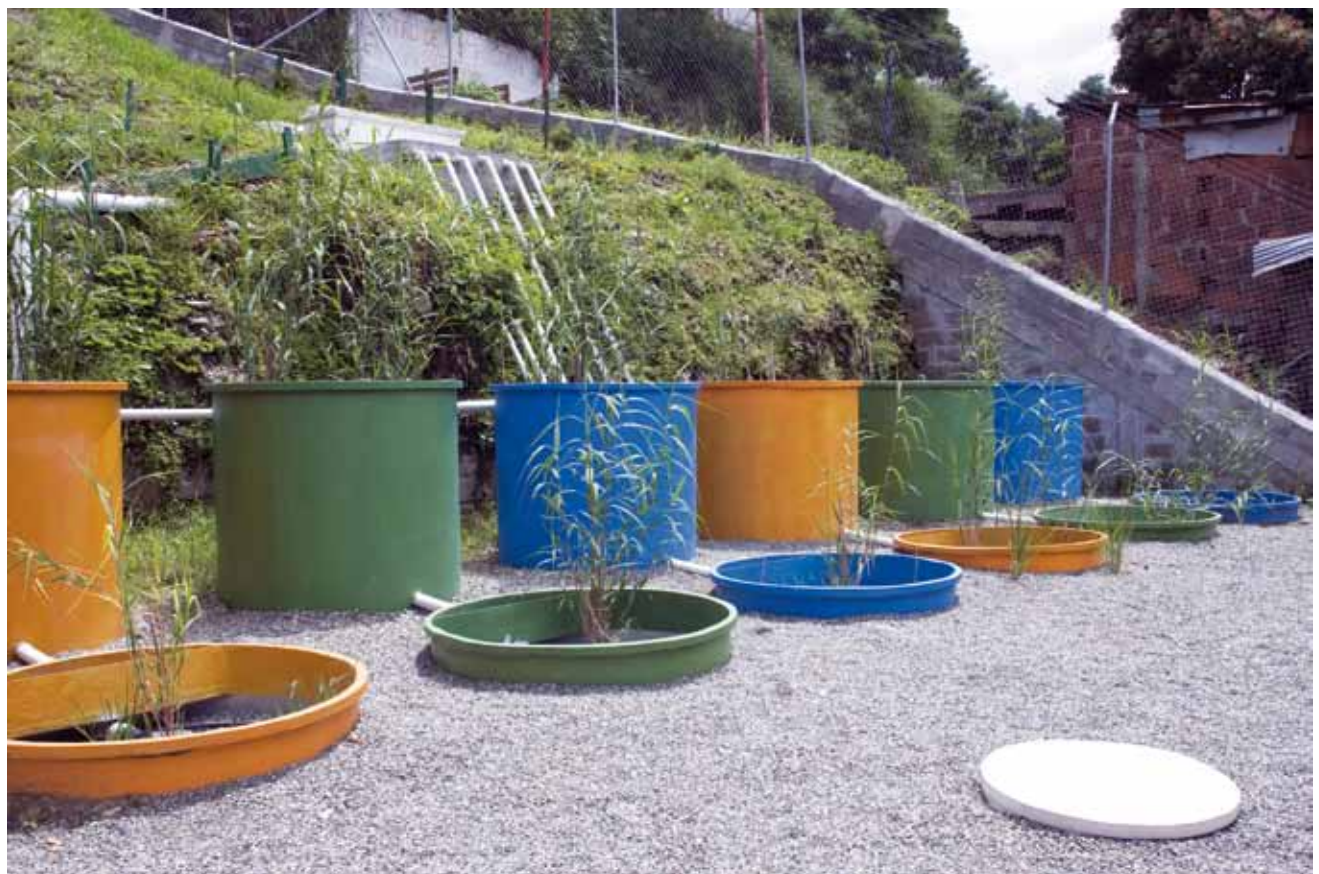
Figura 9. Ejecución planta piloto para el tratamiento de lixiviados. ©2010 Óscar Flecha.
