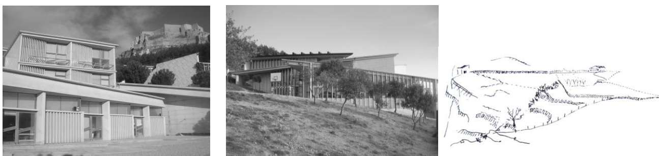
Fig. 4 Fachada sur; Fig. 5 Fachada oeste; Fig. 6 Dibujo de Miralles del entorno del solar de proyecto.
