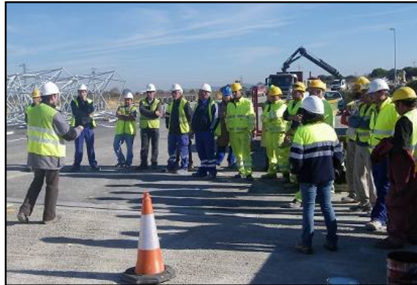
TMA formando a los trabajadores en un tajo de Obra Civil
