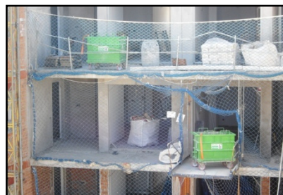
Acopio de RCDs en contenedores de tajo al lado de los muelles, como medida alternativa cuando no hay espacio en el Punto Verde.
