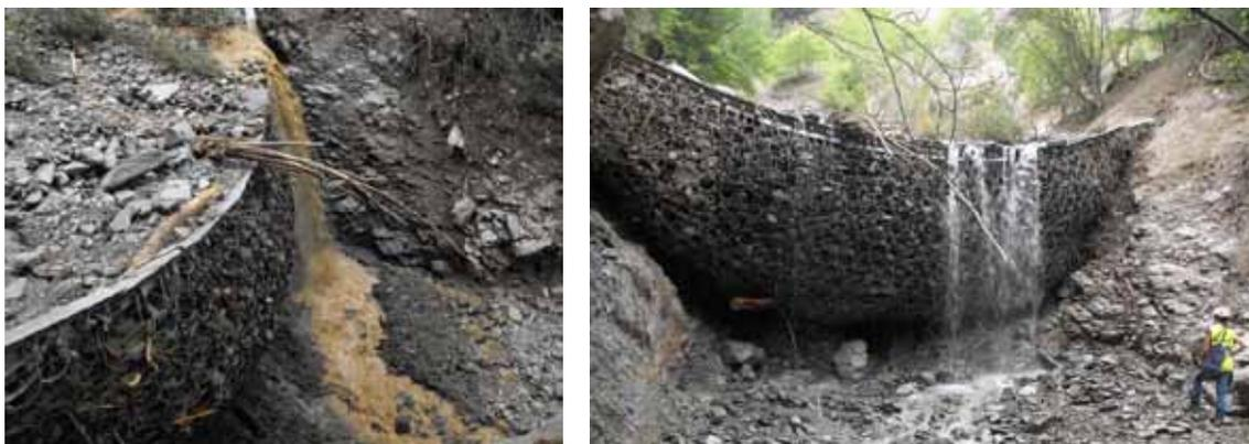
Figura 7: Vista lateral y frontal de una de las protecciones VX-160 instaladas en el Barranco de Portainé tras el evento de 2010.
