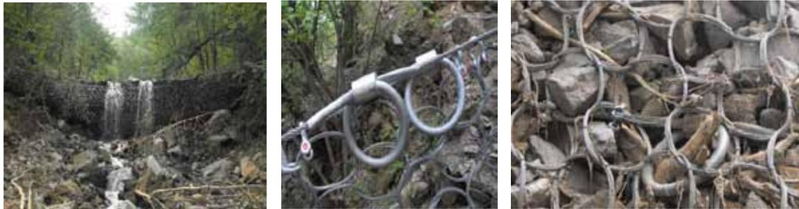
Figura 5: Imágenes de las protecciones VX-160 tras el evento de día 22 de Julio de 2010. (A) Vista general desde aguas abajo, (B) Detalle de los disipadores plásticos (*break rings*) situados en las cables superiores, (C) Detalle de la red de anillos Rocco©.
