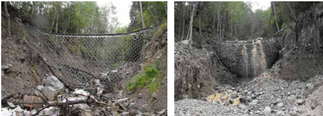
Figura 6: Fotografía “antes y después” de una de las protecciones VX-160 instaladas en el Barranco de Portainé.
