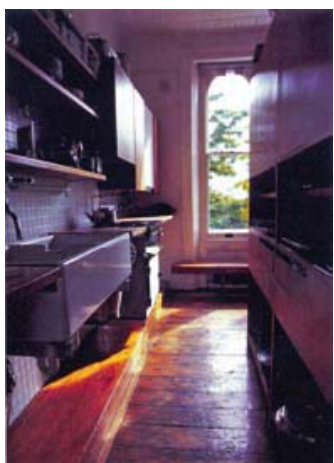
▲ La casa aïllada del número 4 de Gislton Road va ser l'última residència dels Smithson. L'adaptació de la cuina es va fer amb els mateixos criteris que a Priory Walk. L'equipament forma part d'una sala gran que també fa de menjador. Una de les parets llargues s'enrajola amb ceràmica vidriada blanca i s'hi construeix una bancada de cap a cap. Les prestatgeries de taulons de fusta, la pica i la cuina procedent de Priory Walk es penjen d'aquesta paret. En aquest cas, a diferència de la casa anterior, s'instal·la un moble per a la vaixel·la, que separa el banc de cuina de la resta de la sala
