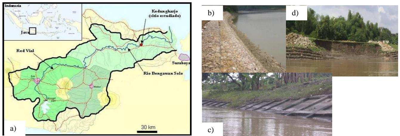
**Figura 1:** a) ubicación de Río Bengawan-Solo, Indonesia (modificado de Sudarsono, 2009); b) corrección con gaviones de roca, después de construcción; c) protección de hormigón; y d) falla de las secciones con gaviones.
