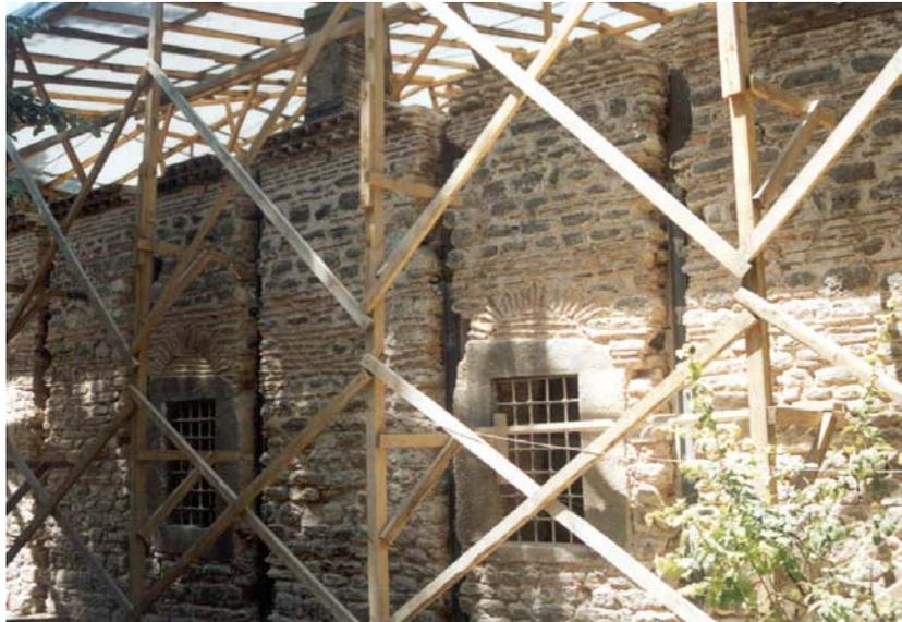
Figura 10 – intervenciones de muy alto coste en forma de pérdida de valor cultural irreversible debido a una excesiva alteración de los materiales y estructura originales. Las bóvedas y arcos de la fotografía superior fueron revestidos con hormigón proyectado tras la colocación del refuerzo observable.
