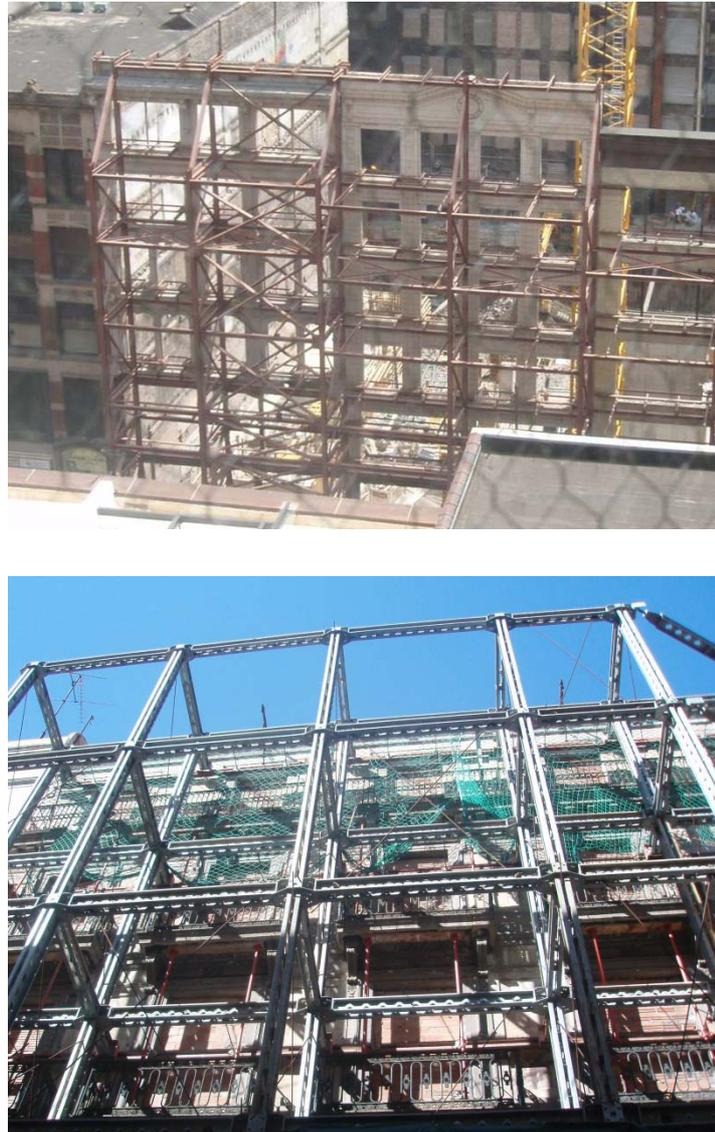
Figura 4 - La preservación exclusiva de la fachada de un edificio antiguo, demoliendo íntegramente los elementos interiores, constituye una práctica claramente contraria a los principios de la conservación del patrimonio arquitectónico en la medida en que menosprecia el valor de la estructura original y de otras muchas facetas del edificio. Fotografías tomadas en Chicago (arriba) y Barcelona (abajo).
