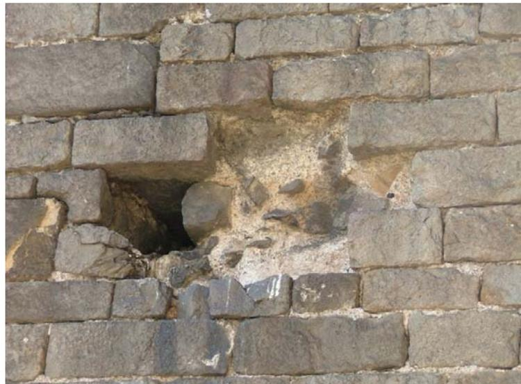
Figura 6 – Daño producido por un proyectil en los muros exteriores de la Basílica de Santa María del Mar en Barcelona, durante la Guerra de Sucesión. Ejemplo de alteración que debería mantenerse como parte de la historia de la propia construcción.
