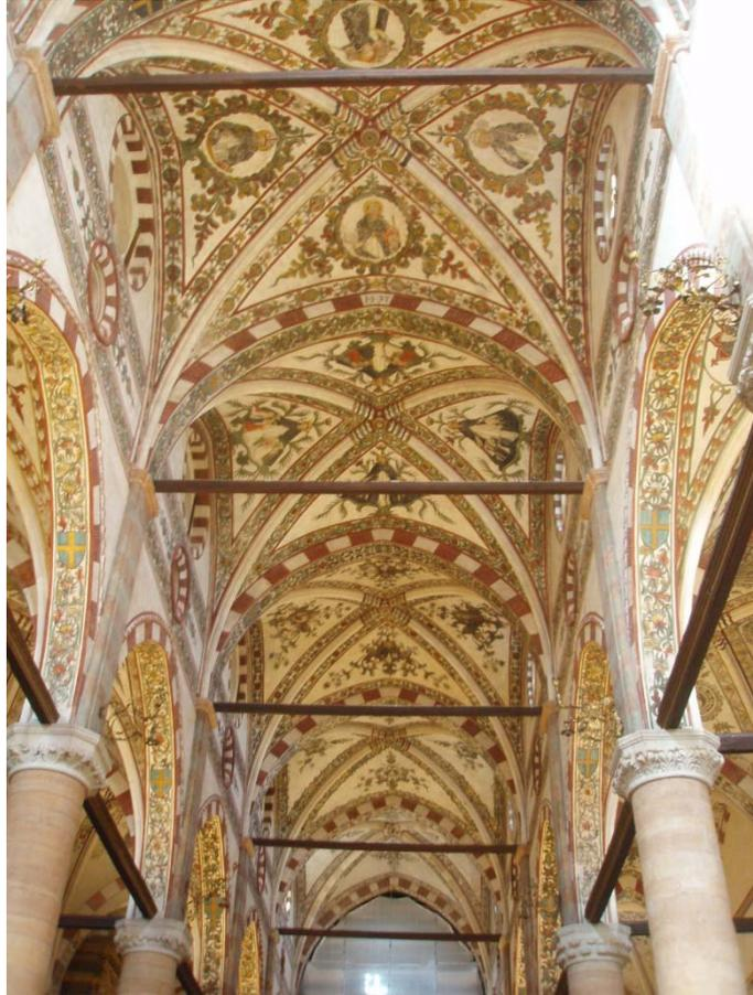
Figura 3 – Bóvedas cruzadas originalmente atirantadas de la Iglesia de Santa Anastasia en Verona. La autenticidad no está únicamente determinada por los materiales y la morfología originales, sino también por los mecanismos y principios resistentes que caracterizan el comportamiento del conjunto.
