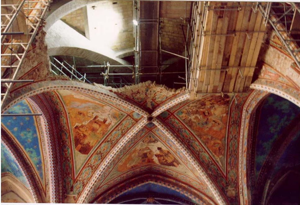
Figura 9 – Colapso parcial de una bóveda de la Basílica de Asís en Italia, provocada por el terremoto ocurrido en 3 de noviembre de 1997. El colapso provocó la pérdida de decoración original de altísimo valor artístico.
