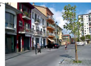
Calle con viviendas de PB y 2 o 3 pisos algunas con locales en Planta Baja. Paso de muchas personas desde y hacia los mercados (Municipal a un lado, Mercadona al otro)
