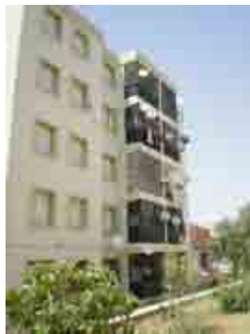
Source BET : HI-TEC, 2005 /APRES Figure 12 : Réfection des loggias[15]
