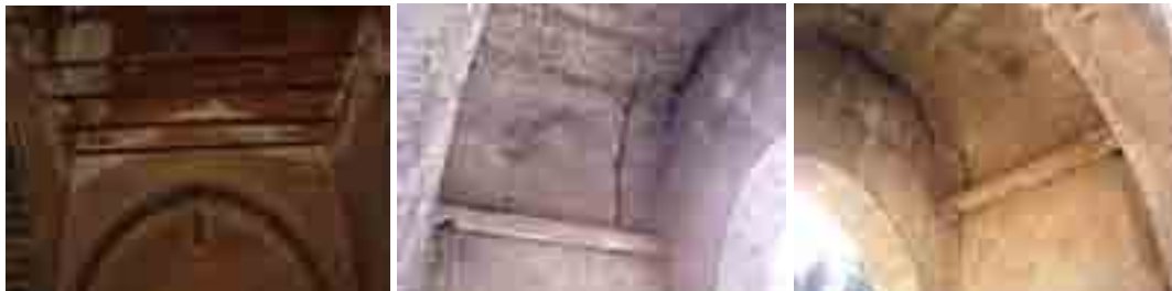
Fig. 6: Tirants métalliques, Rabat et Tirants en bois de stabilisation, Meknès
