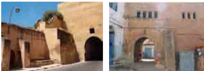
Fig. 3: Muraille avec contreforts à Meknès et Contrefort de Bab Souk à Chefchaouen
