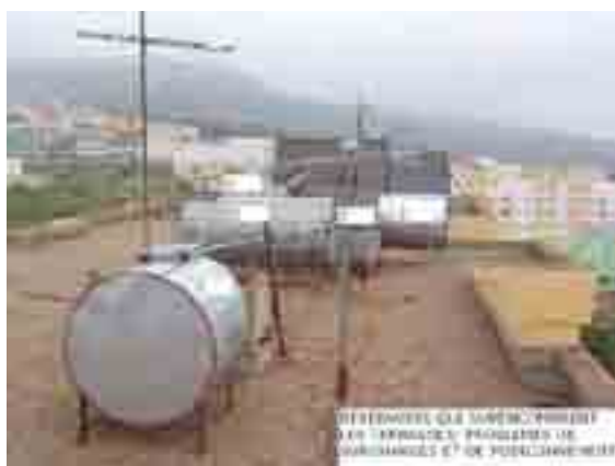
Source BET : HI-TEC, 2005 / AVANT Figure 9: Réservoirs qui sur encombrant les terrasses [15]
