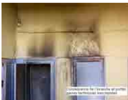
Source BET : HI-TEC, 2005/AVANT Figure 13 : Etat des gaines technique [15]
