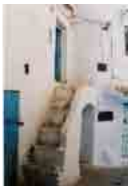
Fig.8: Escalier de confortement, Chefchaouen
