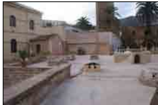
Fig2. L'état du site après sa Réhabilitation.
