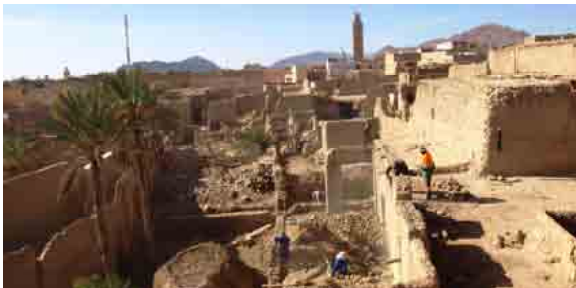
Image 4_ travaux de démolition et construction des nouvelles fondations dans l'école chantier
