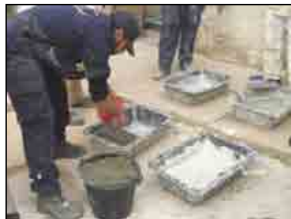
Fig6. Formation en mortiers et enduits de chaux.
