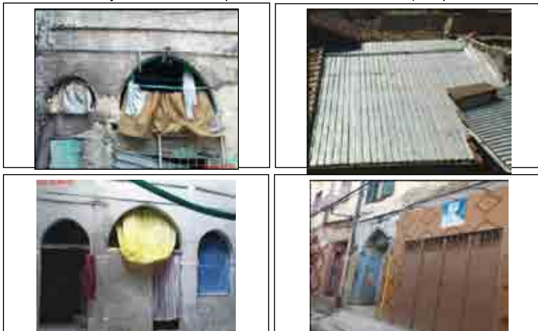
Photos n° 3-4-5-6 : Les exemples de travaux de réparation menés par les propriétaires. Des travaux de réfection sont réalisés par les propriétaires sans de tenir compte de la valeur patrimoniale des maisons traditionnelles.
