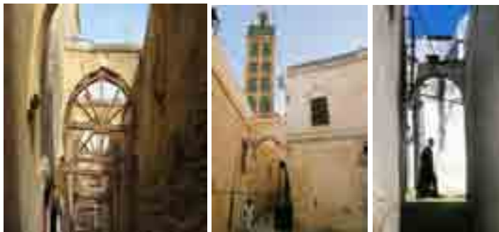
Fig. 4a: Arcs de contraste à Fès, Meknès et Tanger
