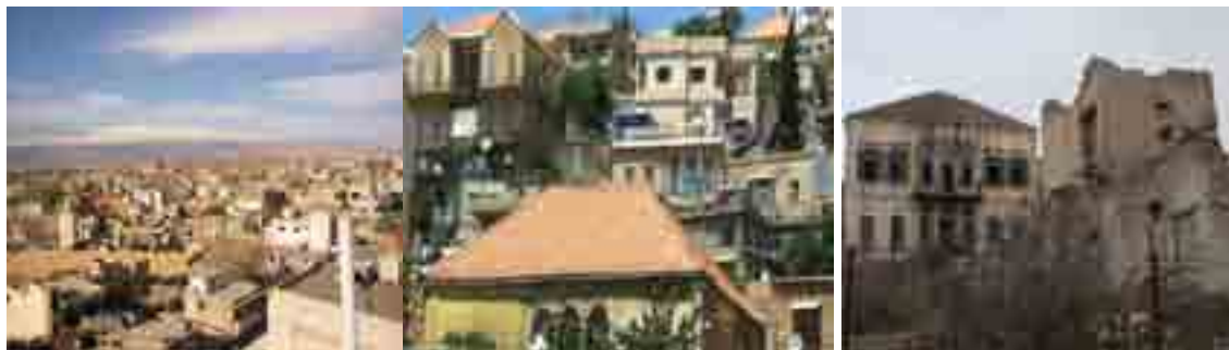
Étalement illégal, dégradation du patrimoine de la vieille ville de Baalbeck.
