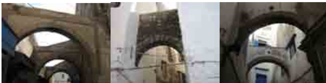
Fig. 4b: Arcs de contraste à Essaouira
