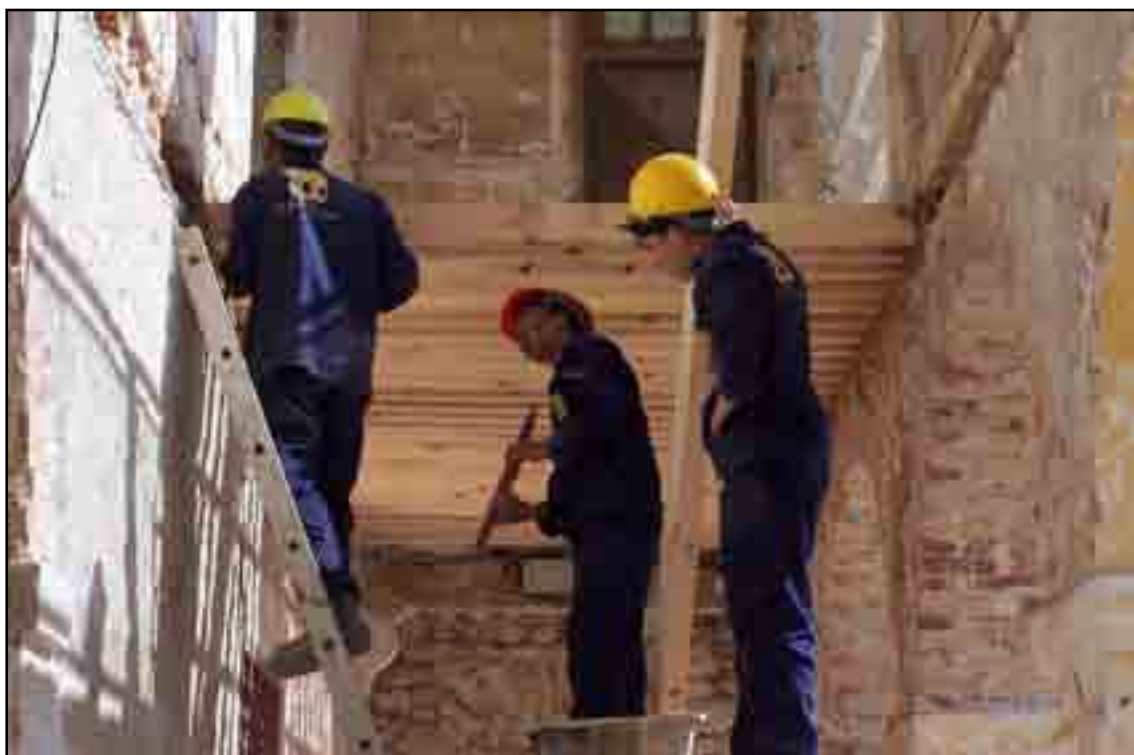
Fig3. Restauration des poutres en bois de l'hôpital du campement.
