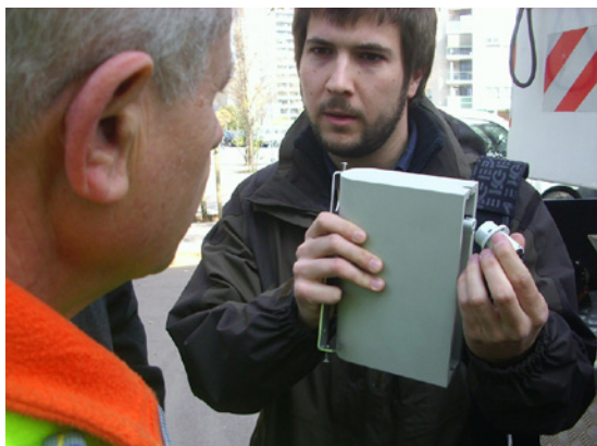
Figura 5: Instal·lació d'un node de comunicacions.
