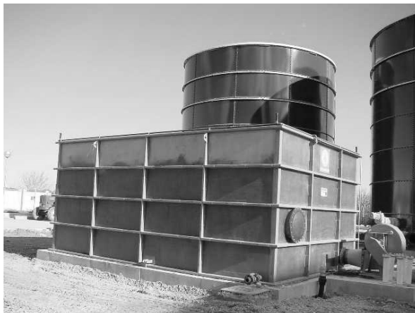
Figura 1. Biofiltro de tratamiento de los gases de proceso procedentes de una planta centralizada de digestión anaerobia de purines de cerdo (Gentileza de TRACJUSA, Juneda, Lleida).
