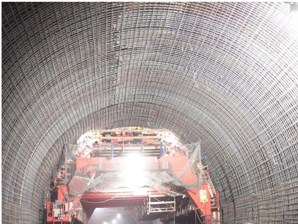
Figura 28: Detalles del armado utilizado en el refuerzo del túnel de Lilla.
