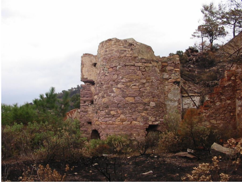
FOTOGRAFÍA 6. Horno de tostación de las Minas de Mercurio de Chóvar
