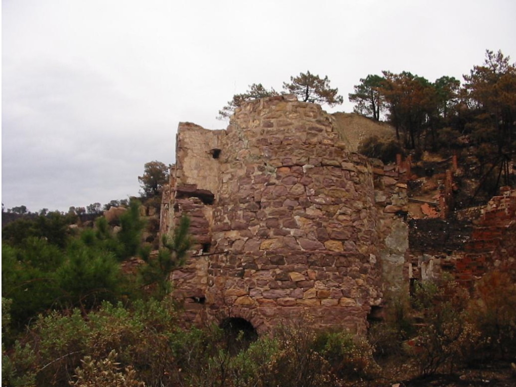
FOTOGRAFÍA 8. DETALLE DE LOS HORNOS DE TOSTACIÓN DEL CINABRIO (CHÓVAR)
