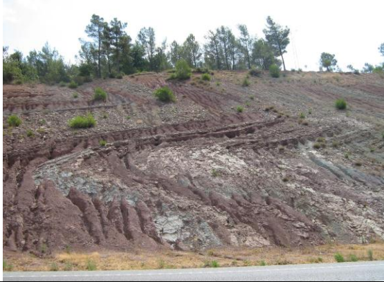
23 Trinchera del Eix Transversal.
