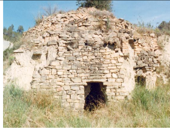
26 Detalle del Forn d'Obra, de Castellgalí
