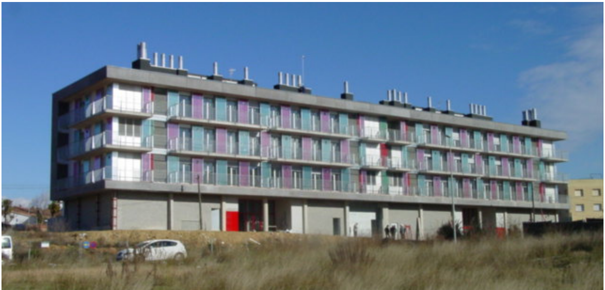
Fig. 2-1. Fotografia de l'edifici
