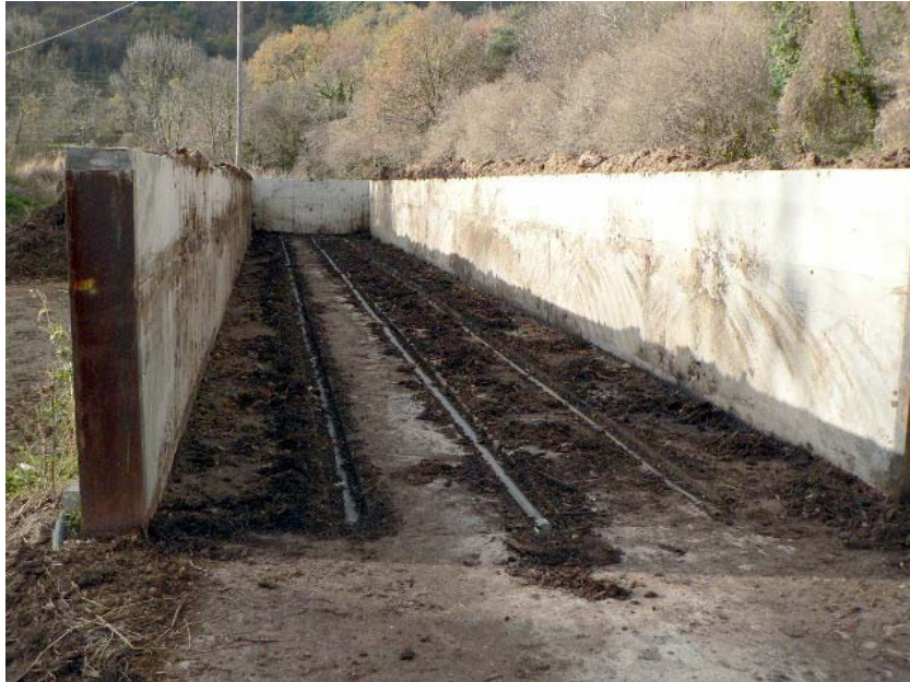
Foto 4. Aspecto en vacío de uno de los silos de compostaje de deshidratado de purín de vacuno (Cooperativa La Fageda - Santa Pau). Se pueden observar las zanjás hechas en la solera, donde se sitúan los tubos perforados que sirven para inyectar el aire al material.
