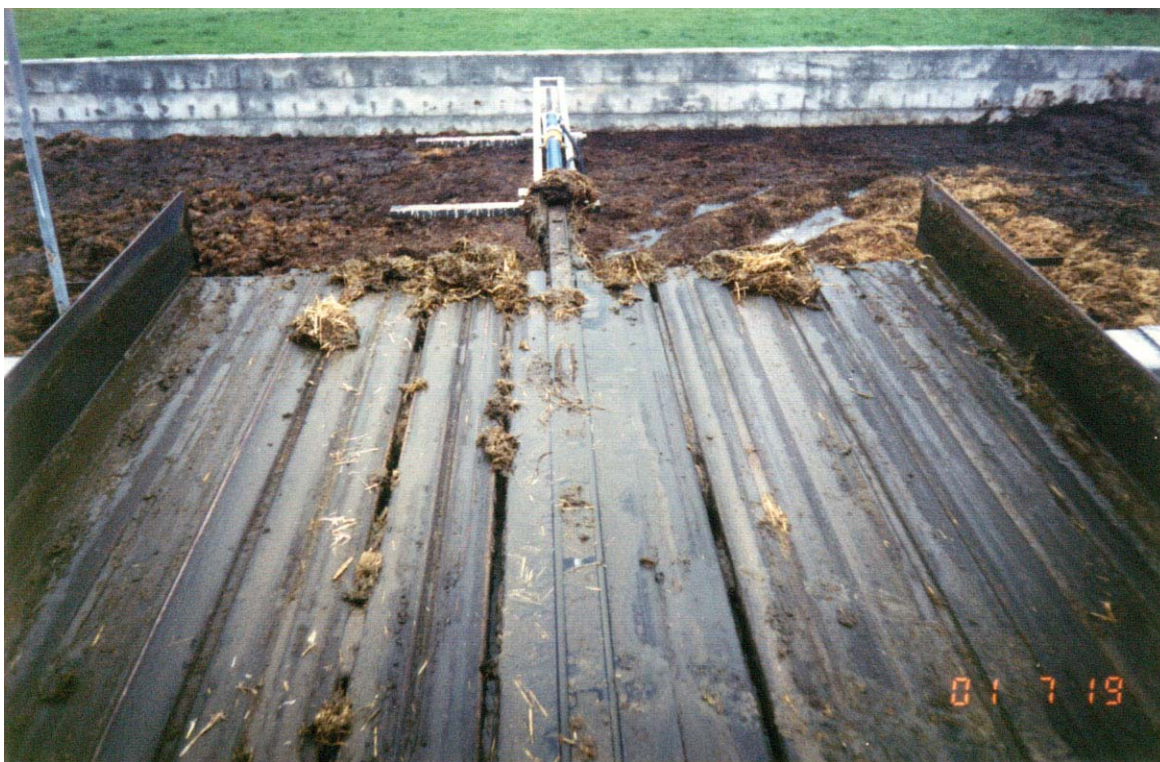
Figura 2. Tamiz formado por un entramado de viguetas en T separadas unos 3-4 cm, y situado al final del pasillo. La fracción líquida pasa a una fosa situada bajo el tamiz y está separada por un muro del estercolero, donde cae la fracción sólida
