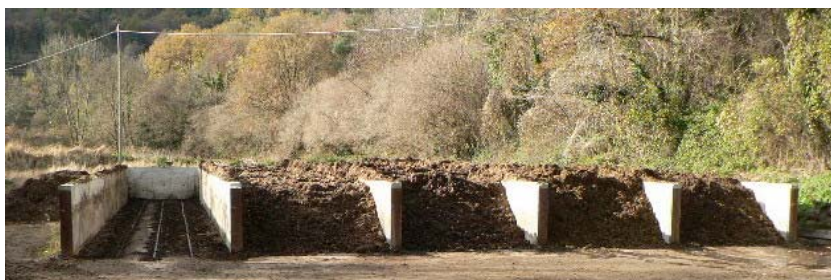
Foto 3. Silos de compostaje de deshidratado de purín de vacuno (Cooperativa La Fageda - Santa Pau). Los silos se construyeron para aprovechar mejor la poca superficie disponible.
