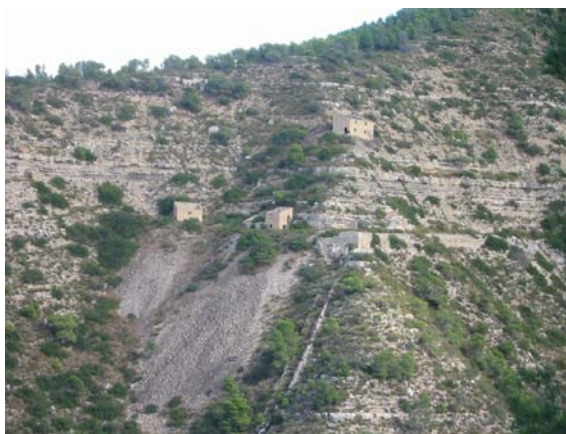
Foto 1. Aspecto de las instalaciones externas por encima del malacate
