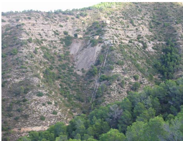
Foto 5. El primer malacate, al fondo. También se ven intactos algunos edificios de las instalaciones mineras.
