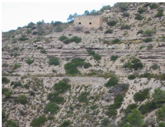
Foto 2. Tramo del ferrocarril minero hasta el primer malacate
