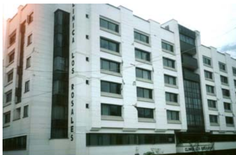
Figura 13: Edificio en la zona del Eje Cafetero de Colombia, dañado durante el terremoto de 1999.
