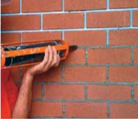
Şekil 3.40. Tuğlaların Arasına Özel Yapıştırıcıların Uygulanması
