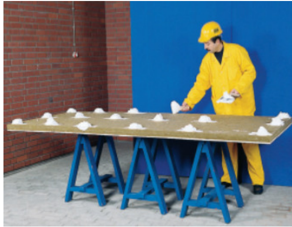
Şekil 3.19. Yapıştırıcı Harcın Yalıtım Levhasına Noktasal Olarak Uygulanması
