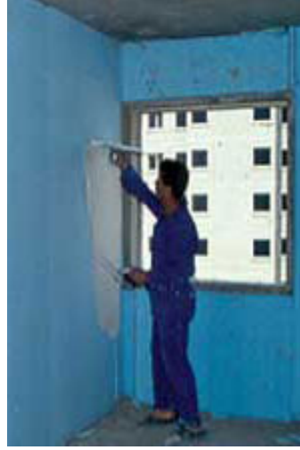
Şekil 3.46. Isı Yalıtım Levhasına İlk Kat Sıva Uygulaması
