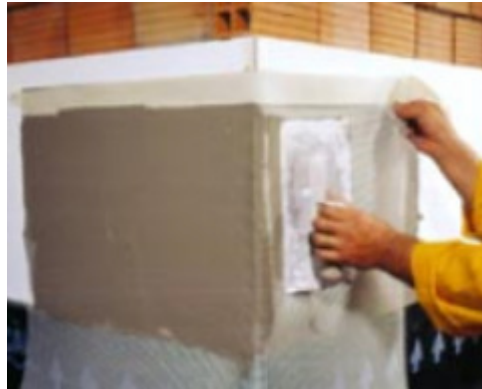
Şekil 3.35. Donatı Filesinin İlk Sıva Katmanı Üzerine Uygulanması
