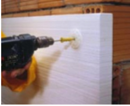
Şekil 3.24. Delik Delme ve Dübelleme İşlemi
