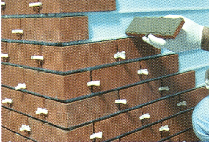
Şekil 3.39. Tuğla Bitişli Son Dekoratif Kaplama
