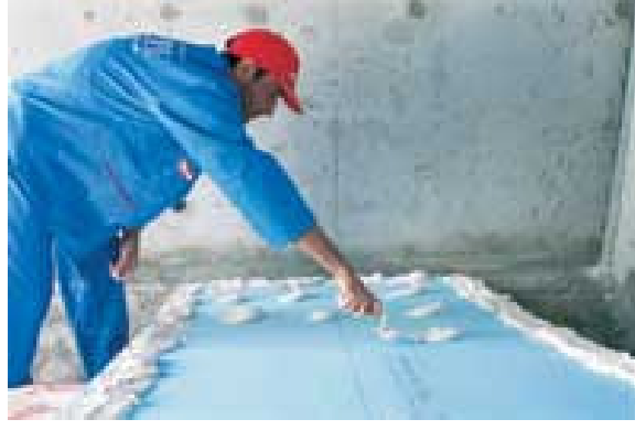
Şekil 3.44. Levhalara Yapıştırma Harcının Uygulanması
