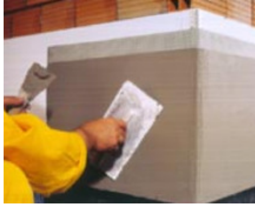
Şekil 3.36. İkinci Kat Sıva Uygulaması
