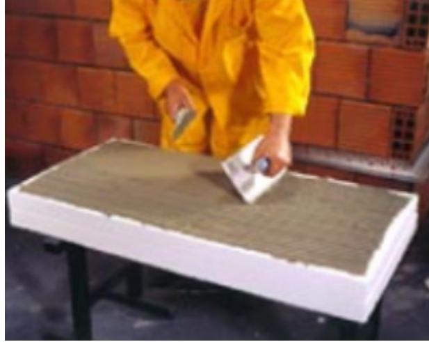
Şekil 3.20. Düzgün Yüzeyle Levha Yüzeyine Tırtıklı Mala İle Yapıştırıcı Uygulaması
