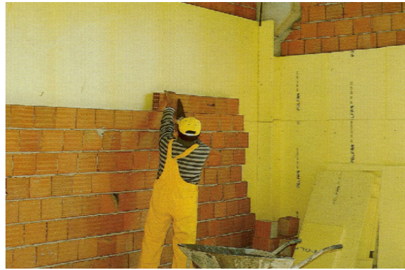
Şekil 3.48. Duvarlarda Ortadan Isı Yalıtımı Uygulaması ve Detayları
