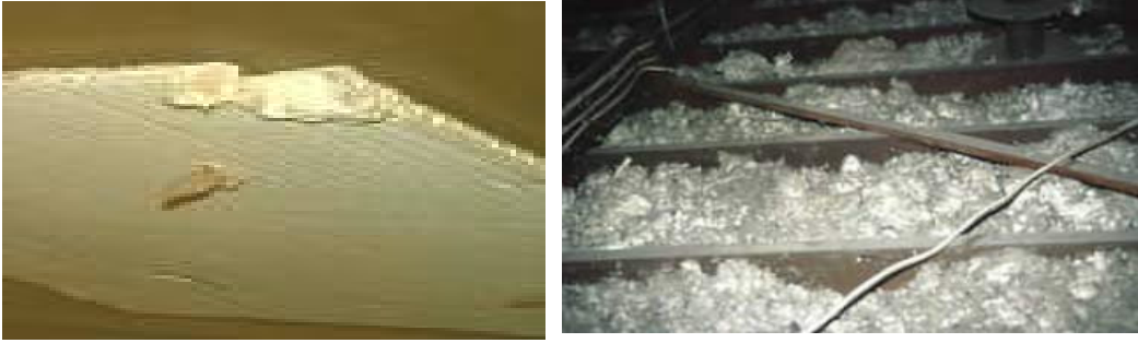
Şekil 2.7. Asbestin Levha ve Lif Halinde Uygulanması
