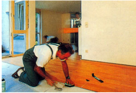
Şekil 2.27. Her İki Tarafı Polietilen Kaplı Levhaların Yapı Zeminine Uygulanması
