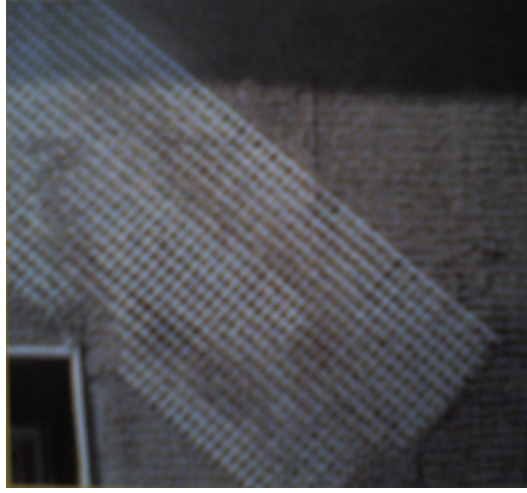
Şekil 3.30. Donatı Filesinin Pencere Köşesine Yatayla 45°'lik Açı Yapar Konumunda Uygulanması
