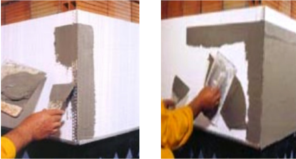
Şekil 3.26. Köşe Profillerinin Uygulanması
