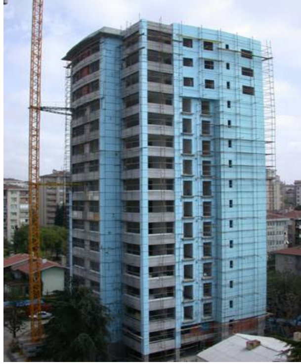
Şekil 3.13. Mantolama Uygulaması
