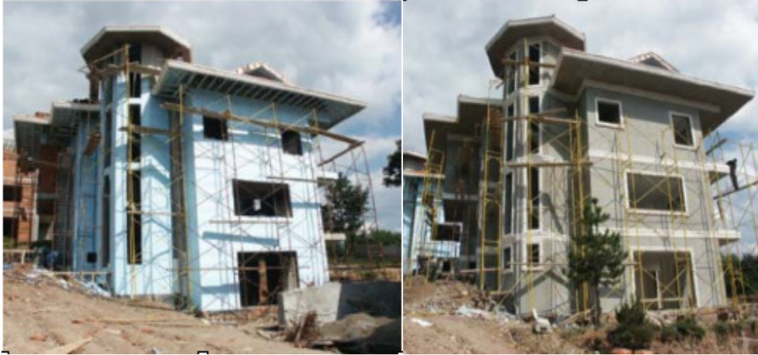
Şekil 3.14. Binalarda Mantolama İşlemi ve İşlemi Takip Eden Yüzey Kaplama İşlemi
