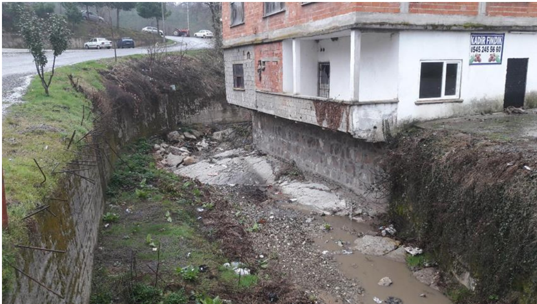
Şekil 2.2. Sakarya Karasu Kızılıcık deresi yatak içine inşa edilen ve kesiti daraltan yapı
