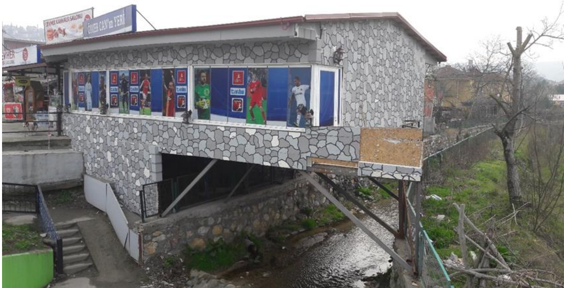
Şekil 2.5. Sakarya Sapanca Sarp Deresi taşkın koruma tesisi üzerine yapılan yapı
