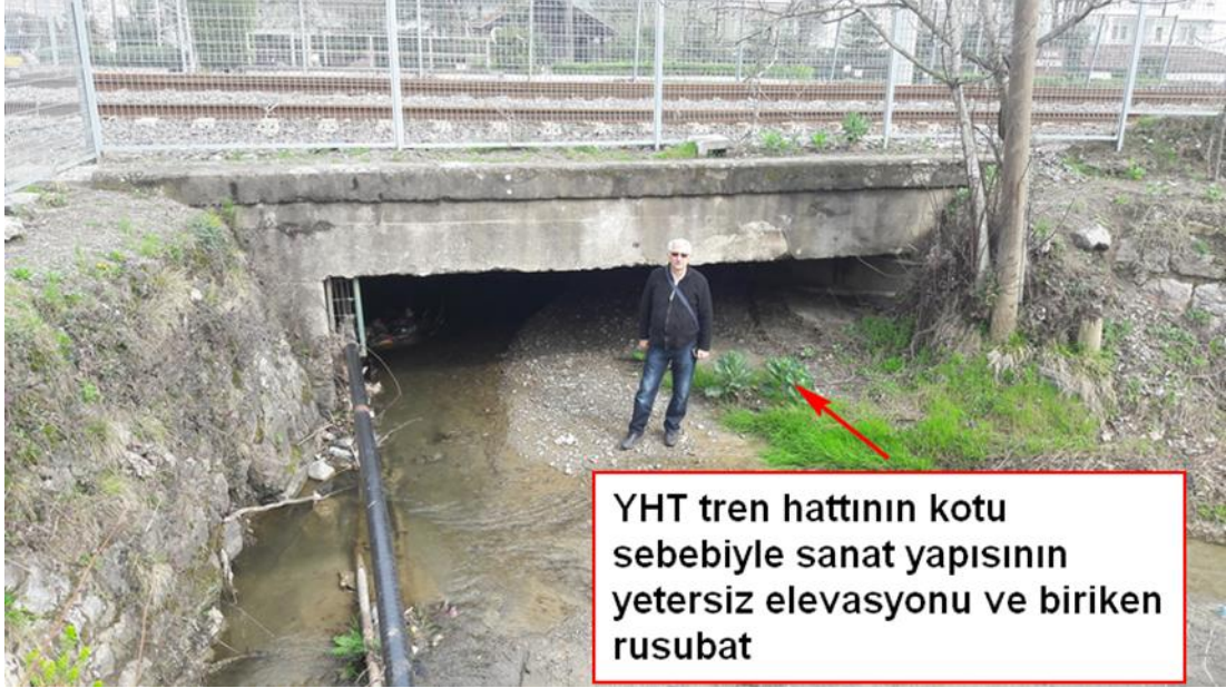
Şekil 2.6. Sakarya Sapanca Sarp Deresi üzerinde inşa edilen yetersiz sanat yapısı ve kesiti daraltan rusubat
