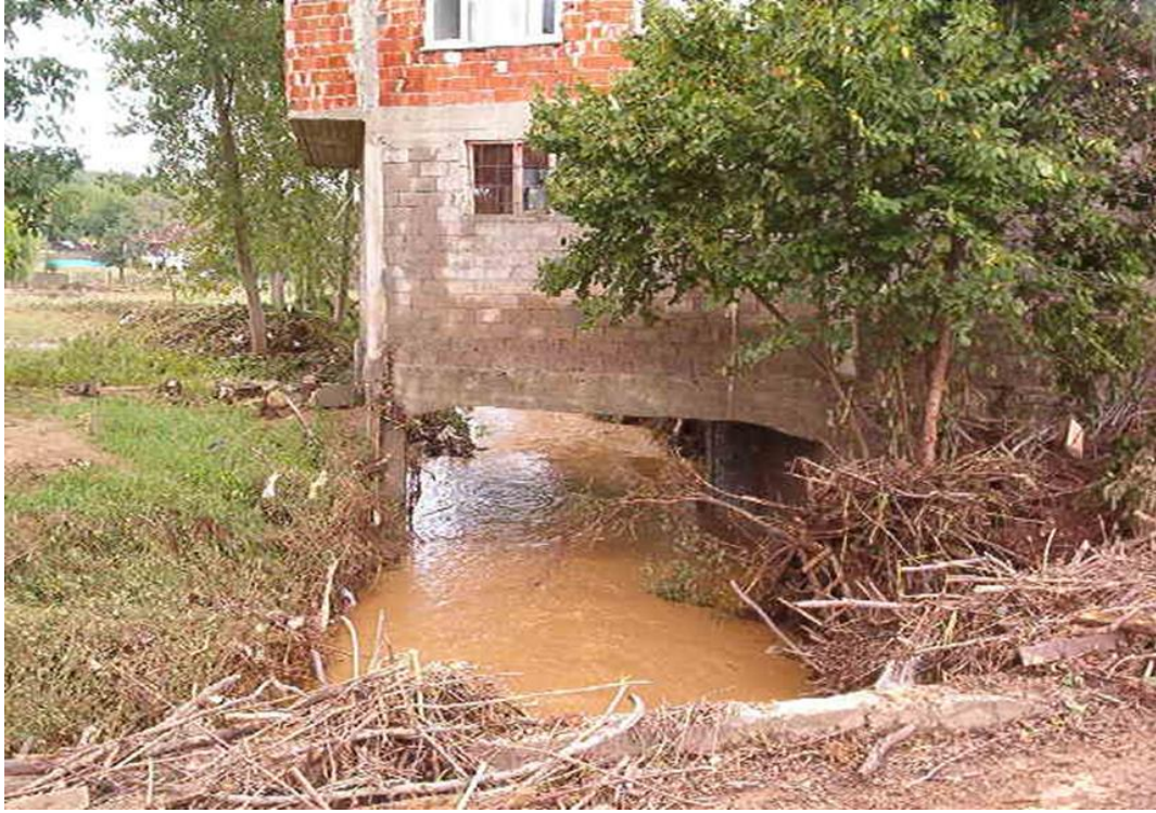
Şekil 2.1. Sakarya, Kocaeli, Demiraçma Deresinde daraltılan kesit (Islah öncesi)
