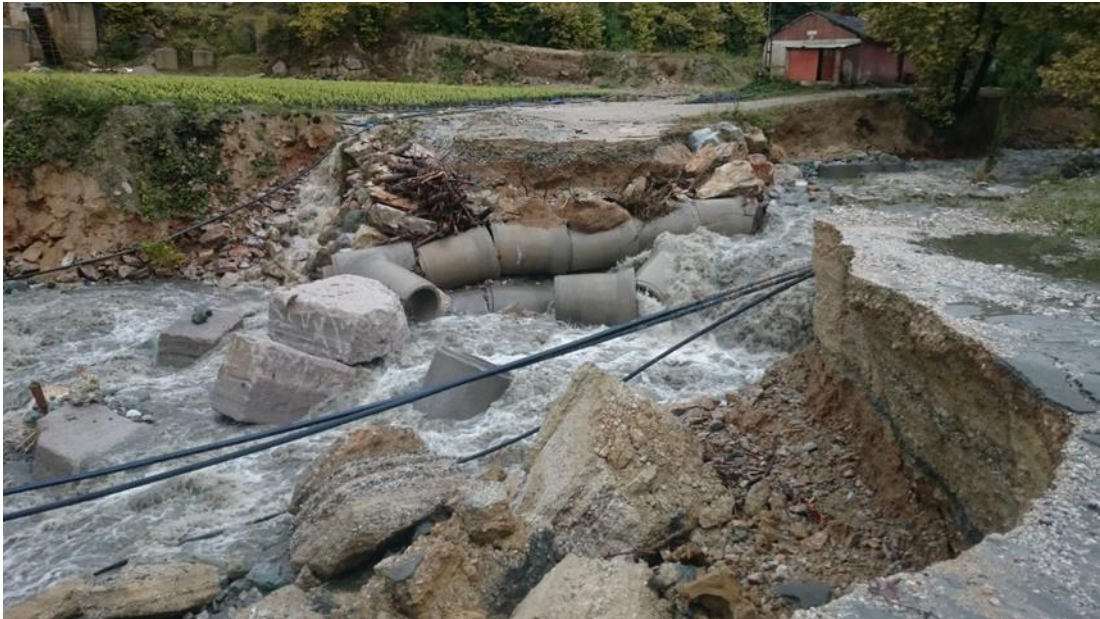
Şekil 5.14. Sapanca Yanık Deresinde hasar gören büzlü geçiş ve yol
