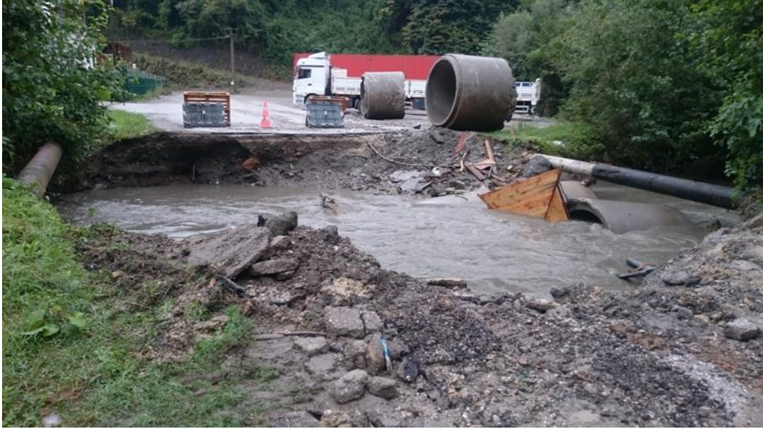
Şekil 5.6. Sapanca Mahmudiye Deresi akışı engelleyen büzlerin kaldırılması
