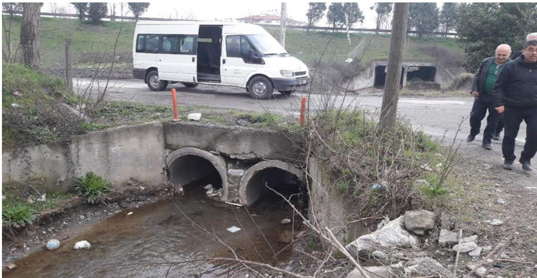
Şekil 2.7. Sakarya Sapanca Keçi Deresinde akışı engelleyen ve kesiti daraltan sanat yapısı
