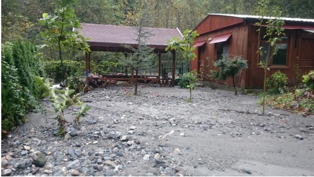
Şekil 5.8. Sapanca İstanbuldere membada rusubatla dolan turistik alabalık tesisi
