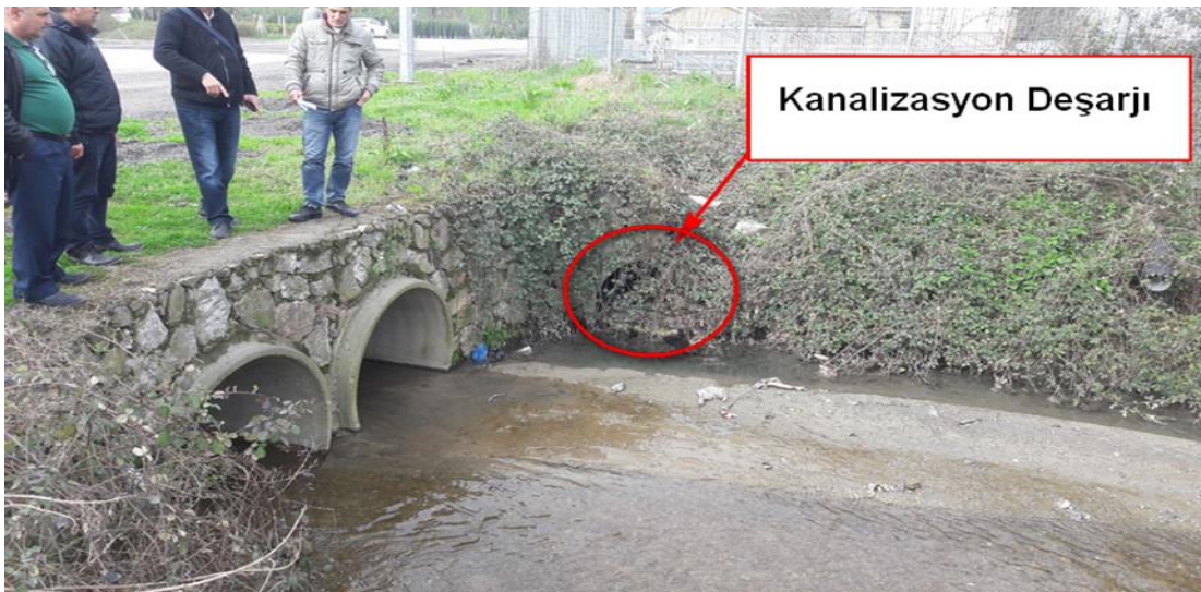
Şekil 2.9. Sakarya Sapanca Keçi Deresinde, dereye kanalizasyon deşarjı
