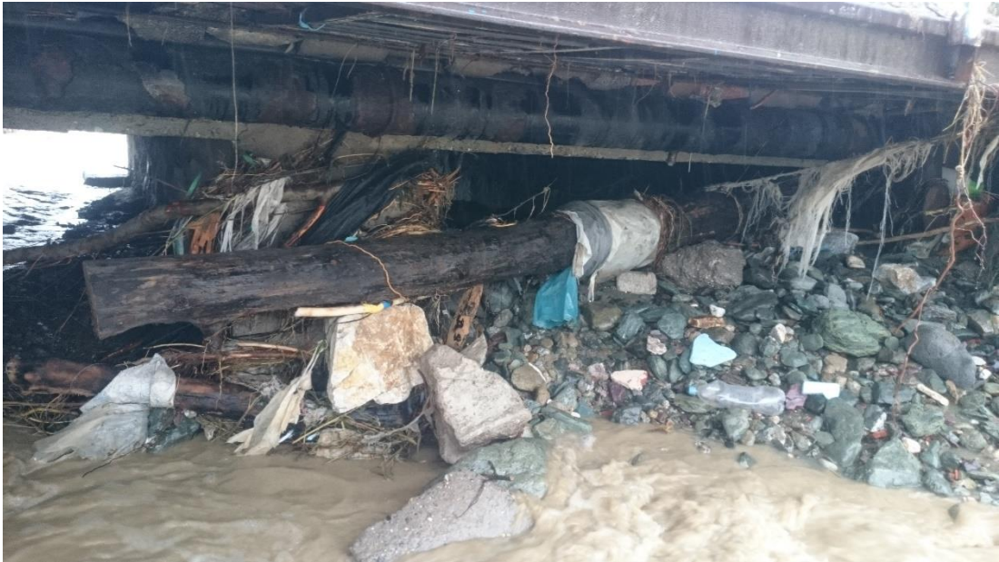
Şekil 5.12. Sapanca Sarp Deresinde yetersiz köprü kesiti ve orta ayak sebebiyle biriken rusubat
