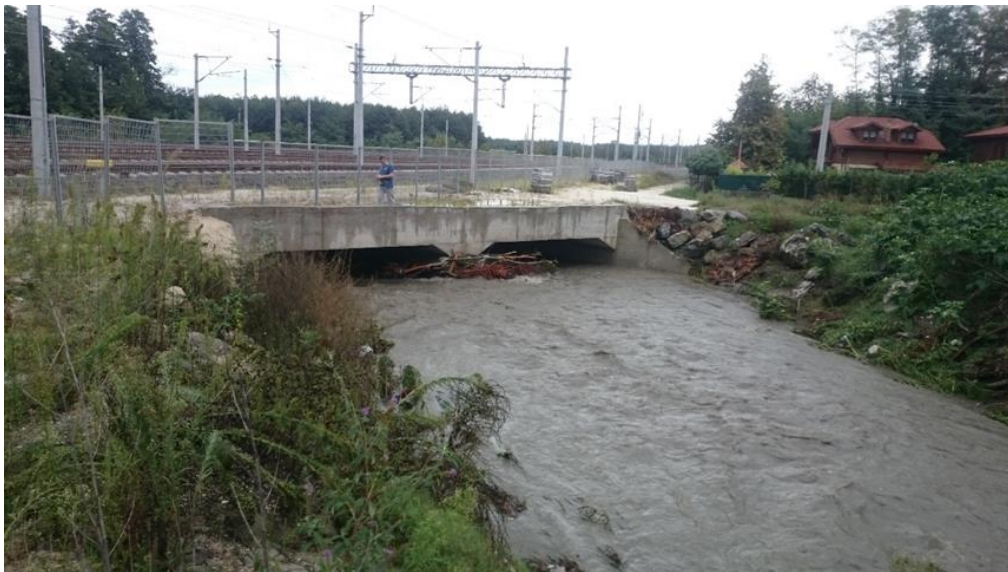
Şekil 5.9. Sapanca İstanbuldere mansabındaki orta ayaklı YHT sanat yapısı
