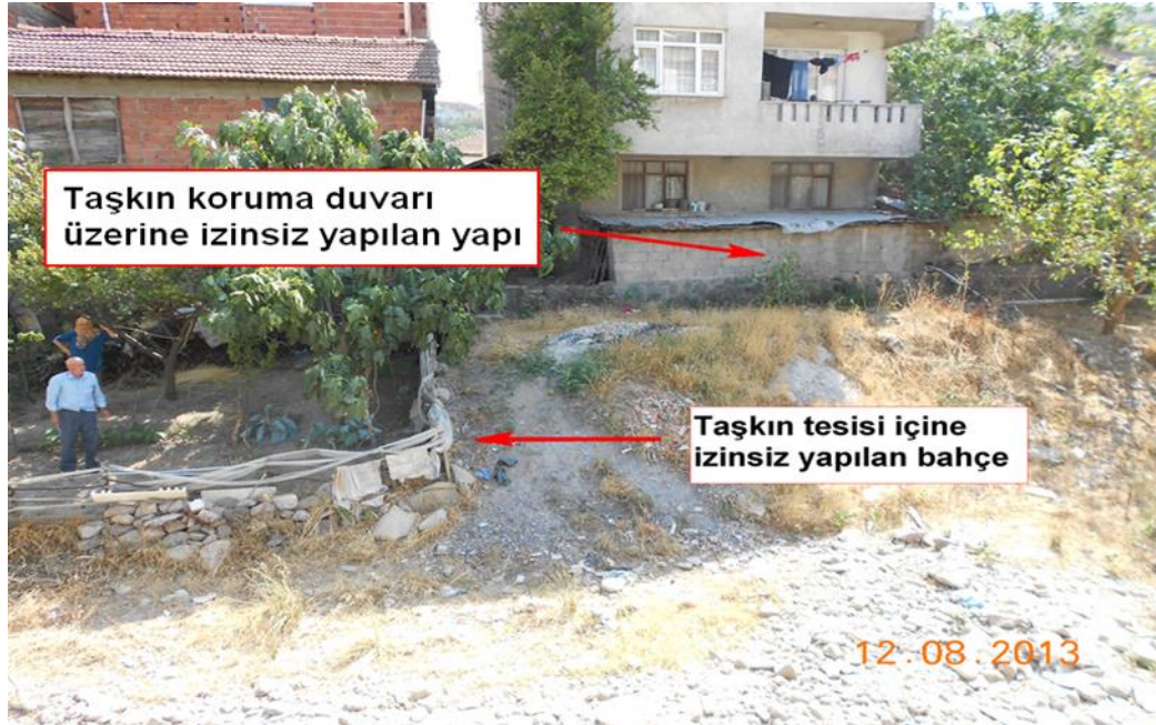
Şekil 2.3. Sakarya Geyve Kıncı Deresi taşkın koruma tesisinin işgali (İslah öncesi)
