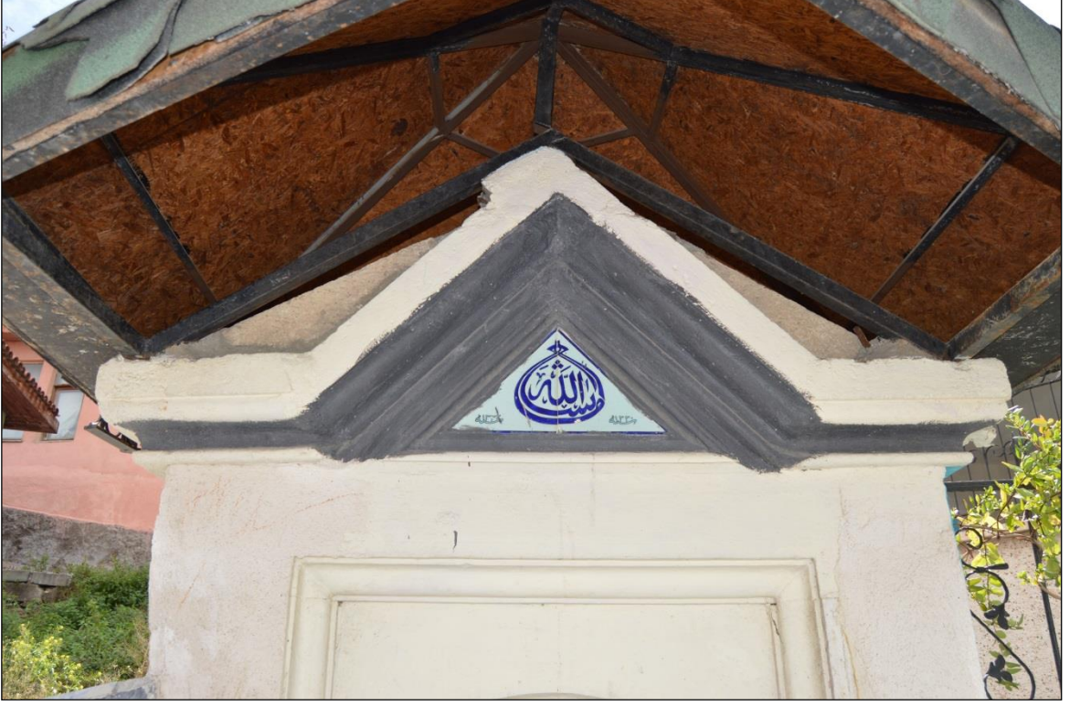
Fotoğraf 70: Çeşmenin Günümüz Malzemesi Olan Çatı Kaplaması (shingle)
