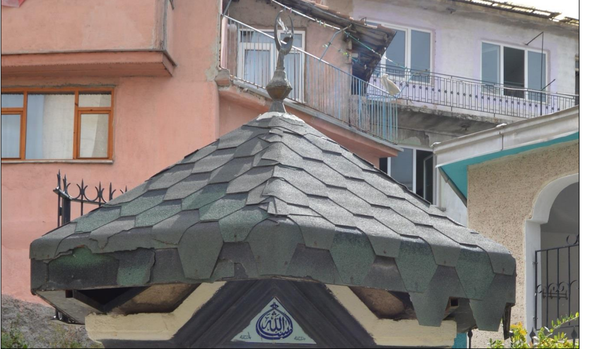
Fotoğraf 70: Çeşmenin Günümüz Malzemesi Olan Çatı Kaplaması (shingle)
