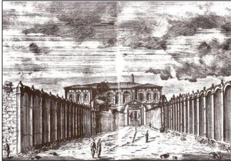
Res.77: Mahmud Raif Efendi'nin Tableau des Nouveaux Reglements de L'Empire Ottoman (1798) adlı kitabında yer alan Mühendishâne-i Berri-i Hümâyûn binasını gösteren bir gravür (www.loc.gov)
