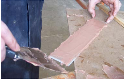
Şekil 3.24. Epoksi uygulaması
