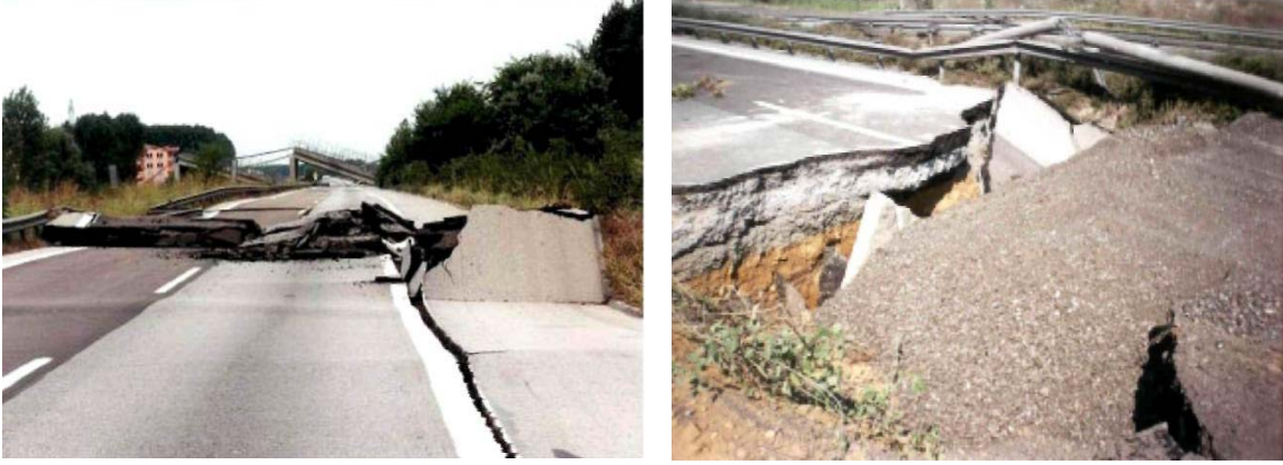
Şekil 4.4 TEM otoyolundaki kabarma ve çökmeler
