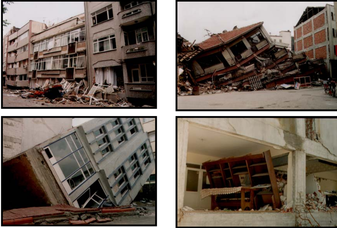
Şekil 2.26. 1999 Doğu Marmara Depremi sonrası Adapazarı kentinde yıkılan ve hasarlı duruma geçen binalar
