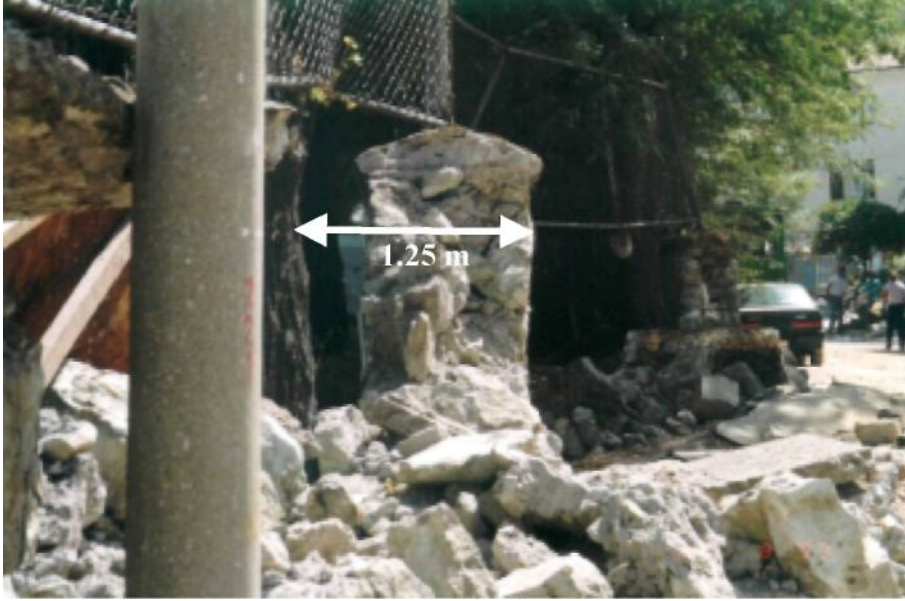
Şekil 2.12. Gölcük Deniz Üssü'nün batı duvarı fay tarafından iki bölümde kesilmiştir. Ön parçanın atımı 1.25 metre, arka parçanın ise 2.75 metredir. Toplam atım 4 metre olarak ölçülmüştür.
