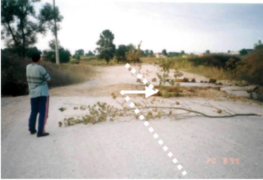
Şekil 2.16. Fayın İzmit Körfezi doğu ucunda denize girdiği bölge ve fay atımının sahildeki direk sırasında meydana getirdiği yaklaşık 2.5 metrelik yanıl yer deęiştirme.
