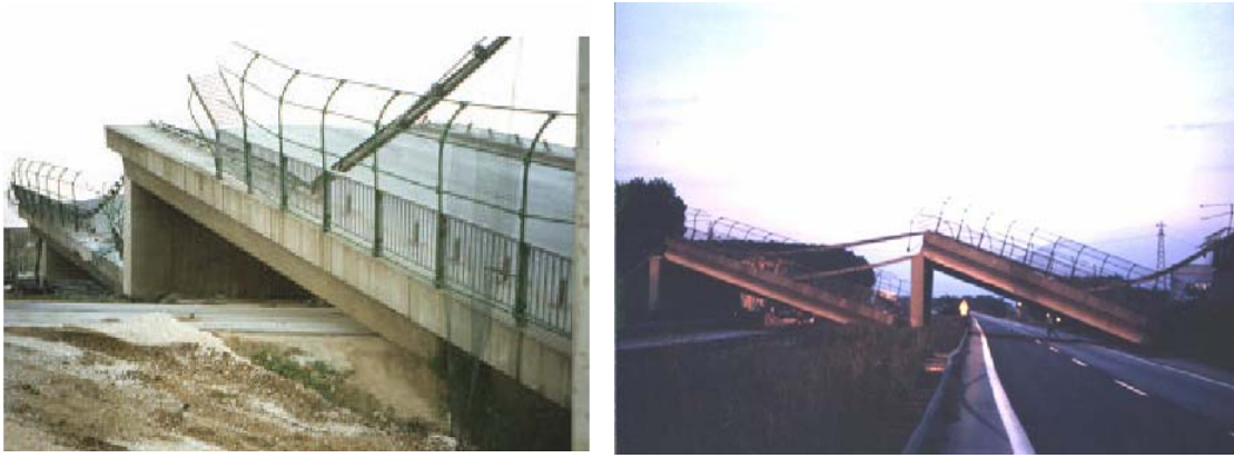
Şekil 4.16. Arifiye üstgeçidi fotoğraflar
